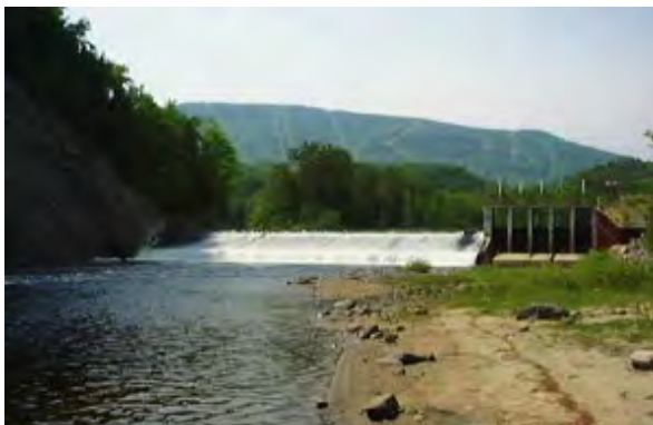
Barrage de Beaupré et vue sur le mont Sainte-Anne © MELCC, Centre d'expertise hydrique
