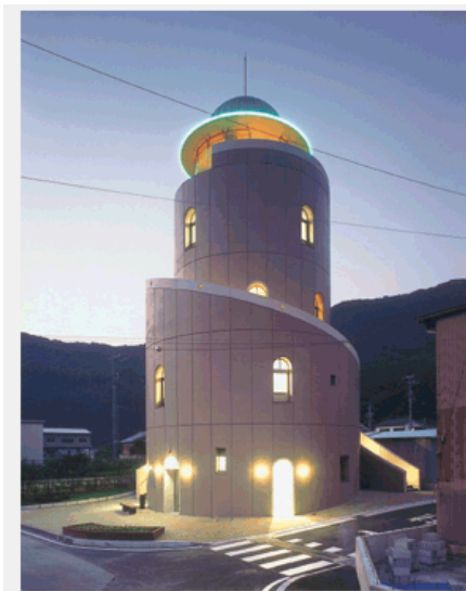
錦タワー全景
