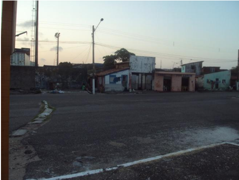
Figura 119 - Esgoto doméstico a céu aberto ao lado do Porto
