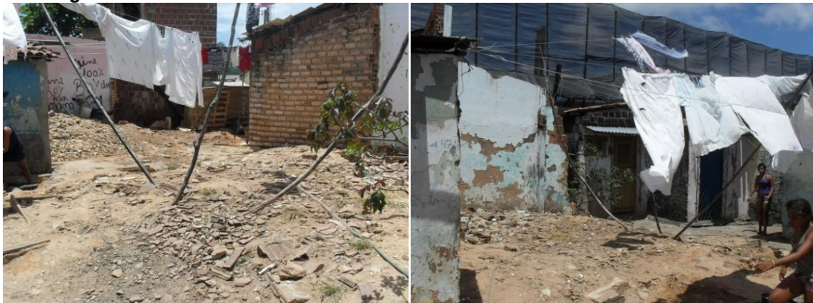
Figura 115 - Locais onde as casas das onze famílias realocadas foram demolidas
