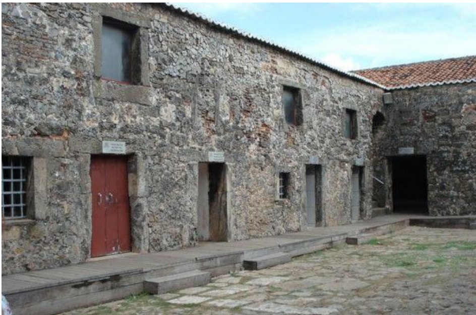
Figura 124 - Forte Três Reis Magos vista interna
