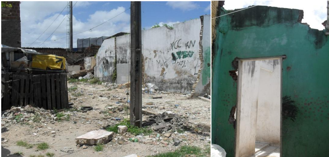
Figura 116 - Locais onde as casas das onze famílias realocadas foram demolidas
