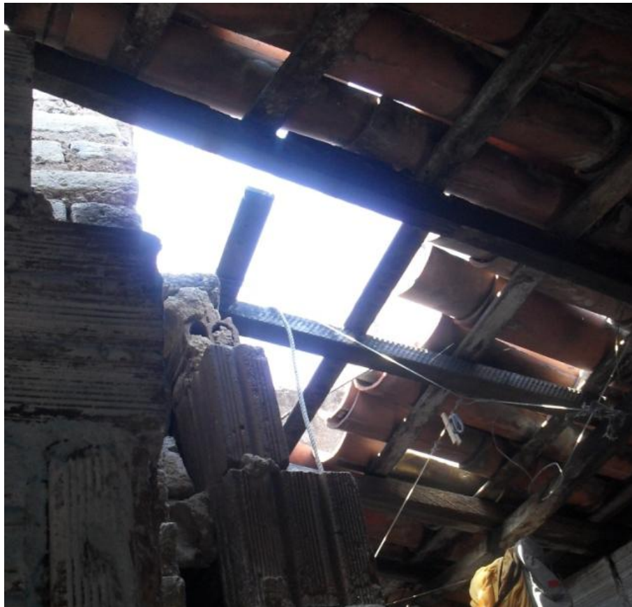
Figura 109 - Destelhamento
