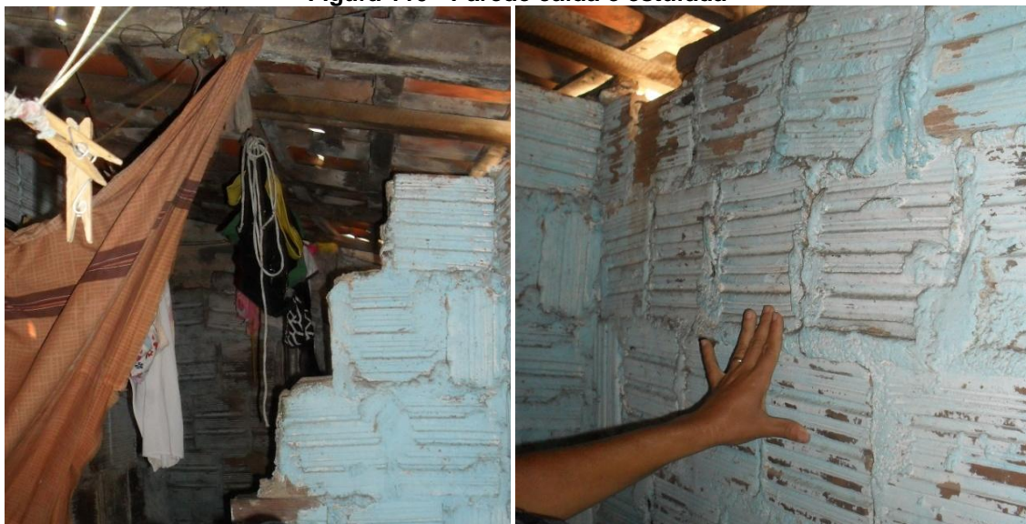
Figura 110 - Parede caída e estufada
