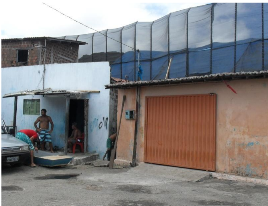
Figura 103 - Casa da foto anterior - Proximidade com o Porto e a tela de proteção para minimizar os impactos da movimentação dos particulados do minério de ferro
