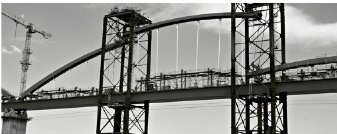
Fig. 49 – Arco em construção [29]
