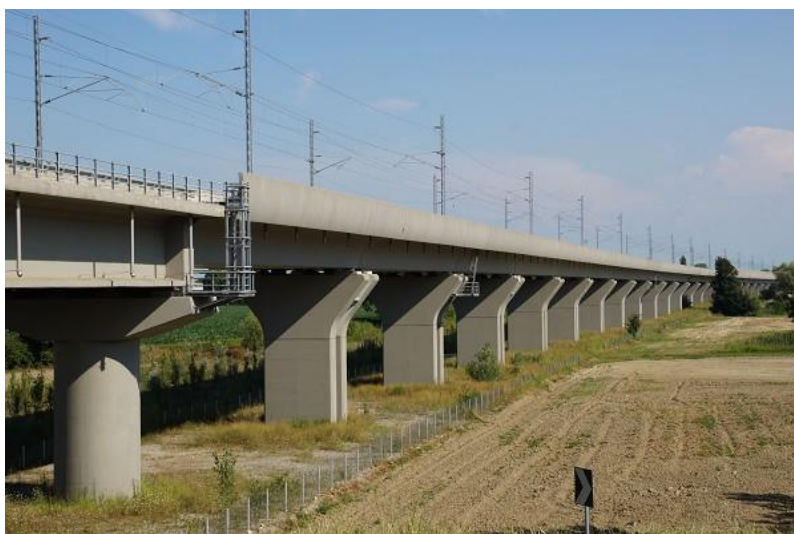
Fig. 21 – Viaduto de Piacenza [21]
