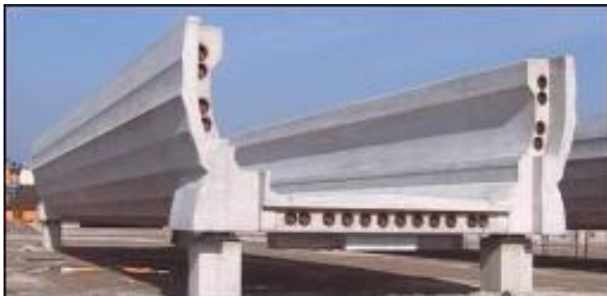
Fig.22 – Secção do Tabuleiro do Viaduto de Modena [22]
