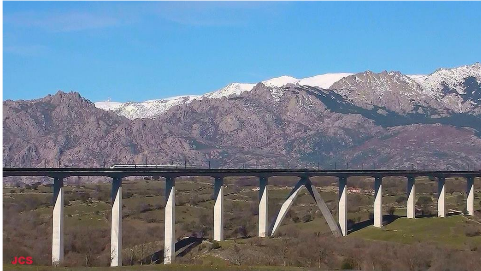
Fig. 15 - Viaduto Arroyo de las Piedras [17]
