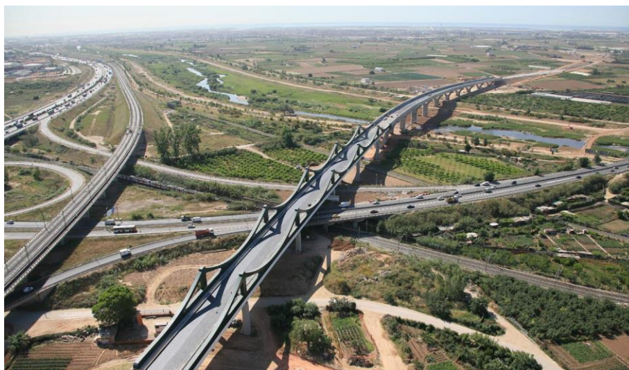
Fig. 16 - Viaduto Sant Boi [15]
