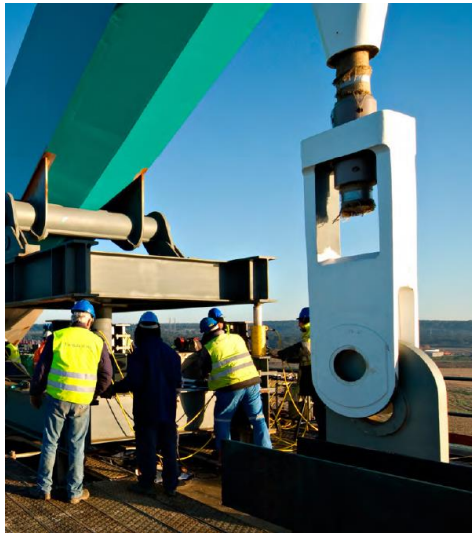
Fig. 50 – Ligação pendural/tabuleiro [29]
