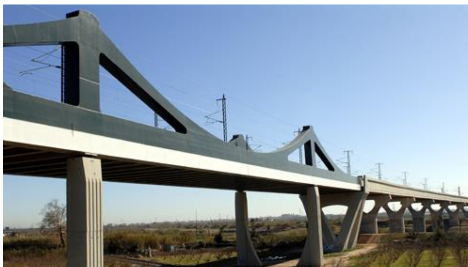
Fig. 17 – Viaduto Sant Boi [15]
