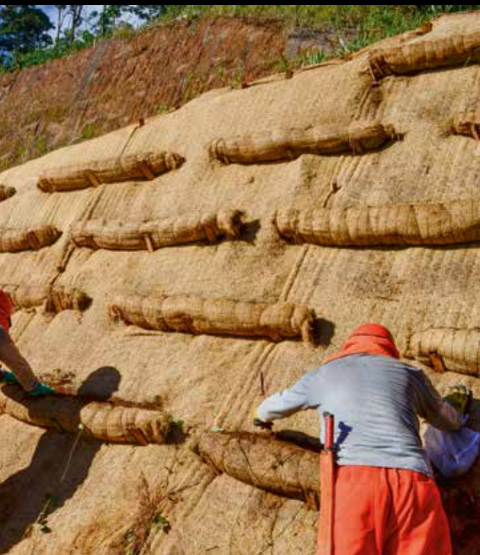
▼ Workers covering the soil to stabilize the slope | Trabajadores cubriendo el suelo para estabilizar la pendiente
