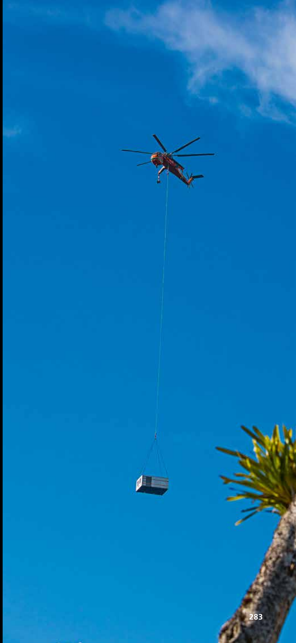
► Cargo helicopter delivering materials to the platform | Helicóptero de carga dejando materiales en la plataforma
