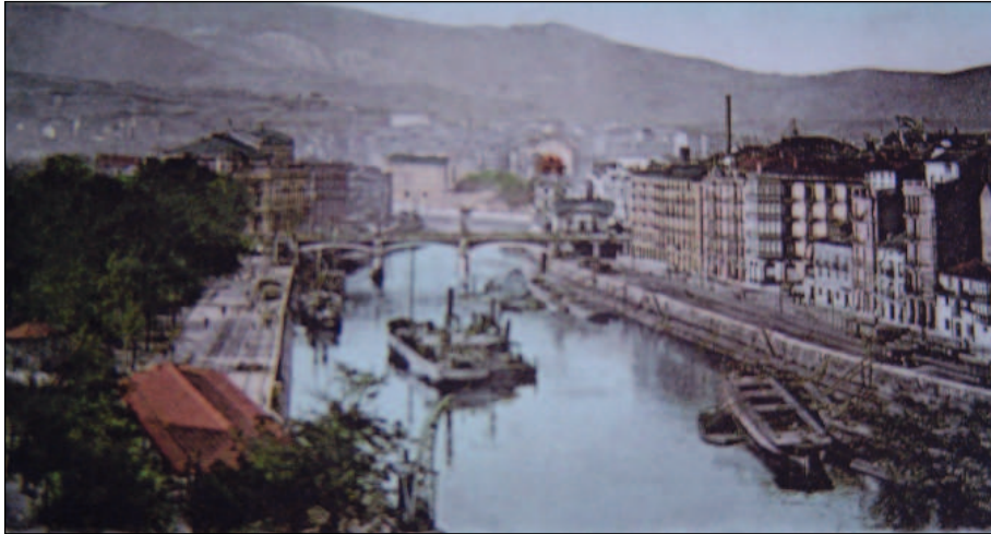
Bilbao, la ría y el puente del Arenal.
