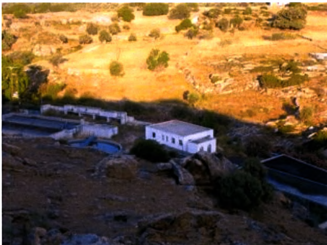
Εικόνα 9: Τμήμα του βιολογικού καθαρισμού πεδινής Νάξου.
