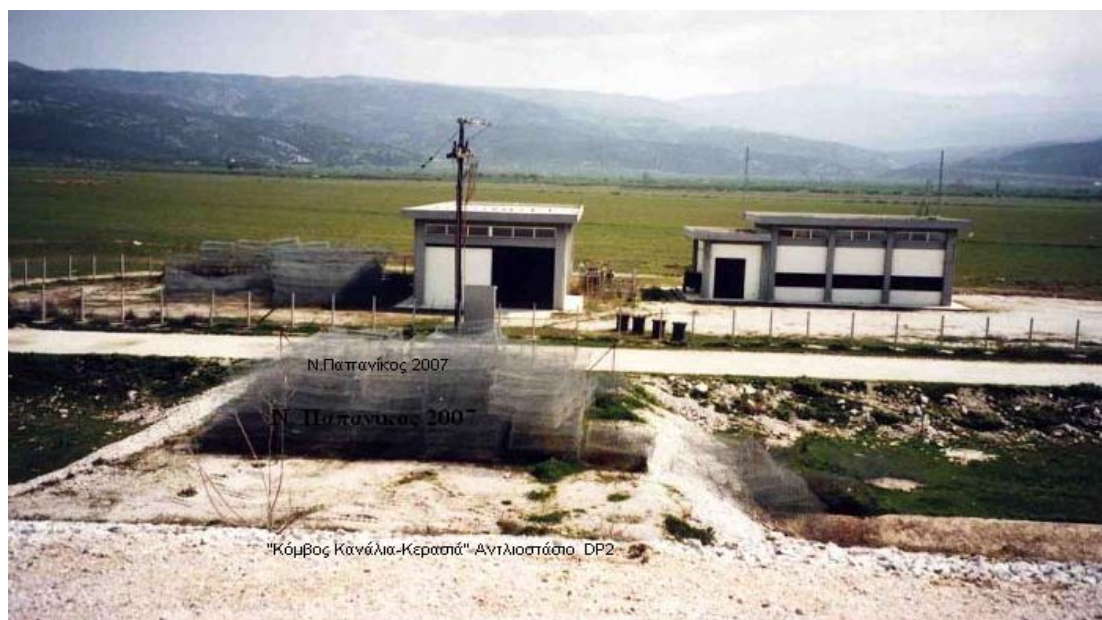
Εικόνα 71. Αντλιοστάσια αποχέτευσης -στράγγισης DP2 και άρδευσης A2.
