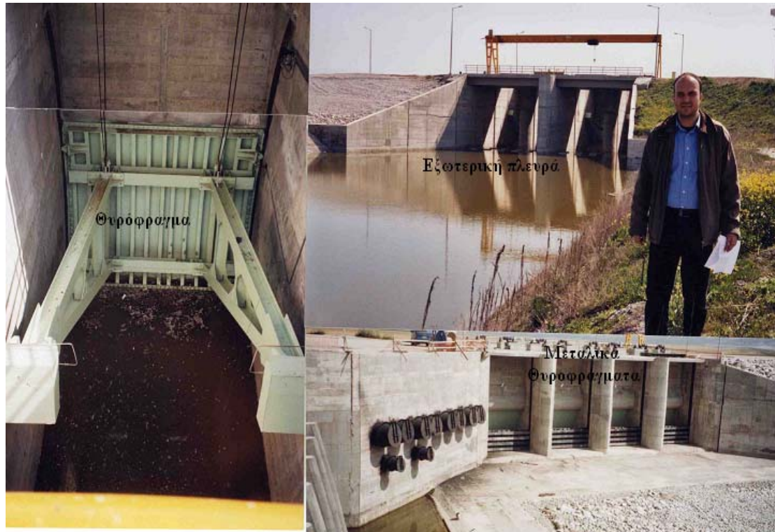
Εικόνα 65. Έργο Ασφαλείας Ταμιευτήρα
