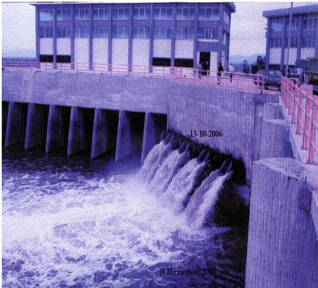
Εικόνα 67. Εσωτερική πλευρά του Αντλιοστασίου DP1.
