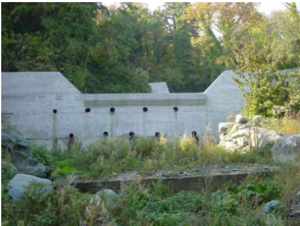
Εικόνα 97: Κατάληξη του φράγματος Νο 14
