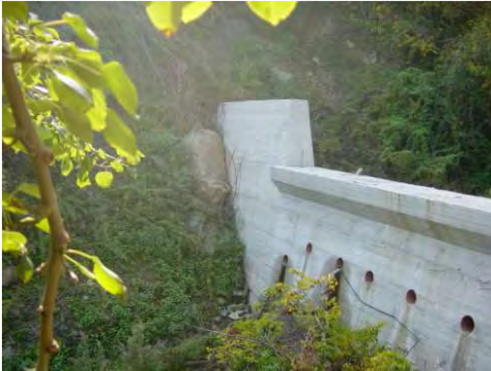
Εικόνα 98: Κατάληξη του φράγματος Νο 15
