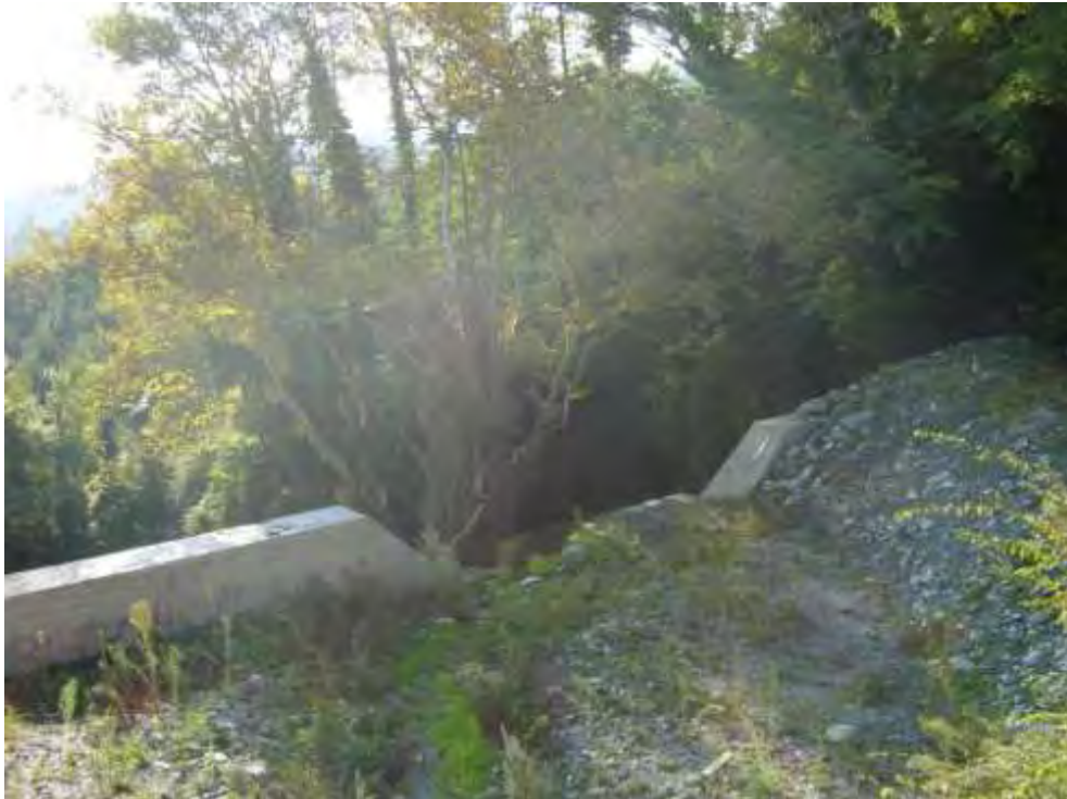
Εικόνα 82: Ανάντη του φράγματος Νο 5
