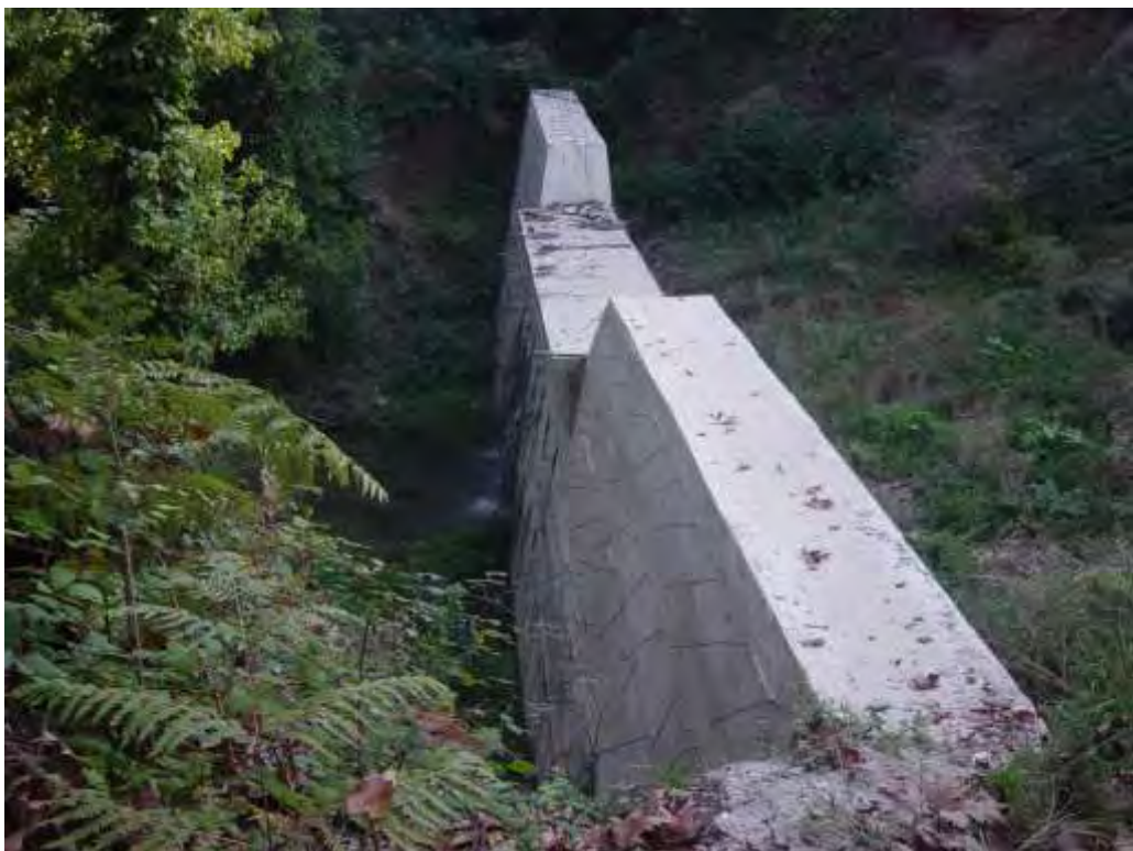
Εικόνα 103: Κατάντη του φράγματος Νο 16
