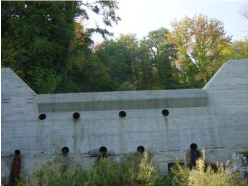
Εικόνα 96: Κατάληξη του φράγματος Νο 14
