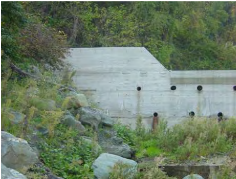
Εικόνα 95: Κατάντη του φράγματος Νο 14
