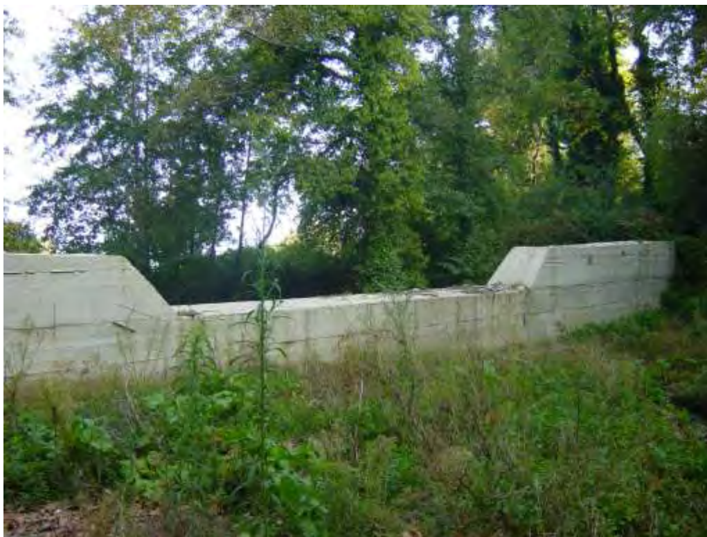
Εικόνα 104: Ανάντη του φράγματος Νο 16
