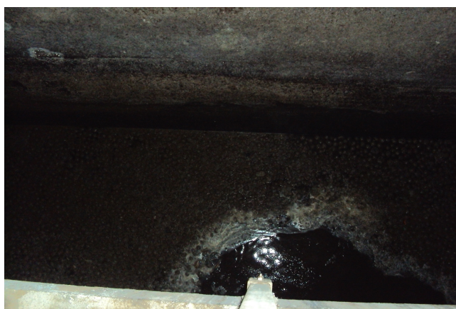
Figura 3 – Poço reservatório da estação elevatória do Molhe Sul
