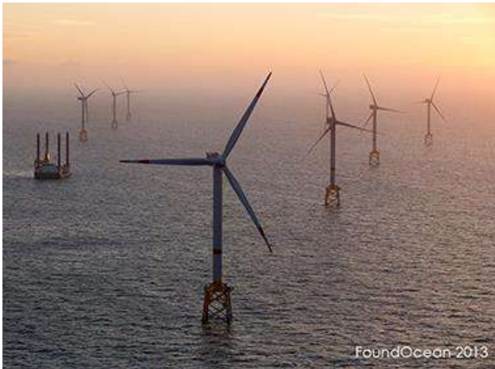
Figura 7. Cimentación tipo jacket en el parque de Thornton Bank, Bélgica (fuente: www.foundocean.com )
