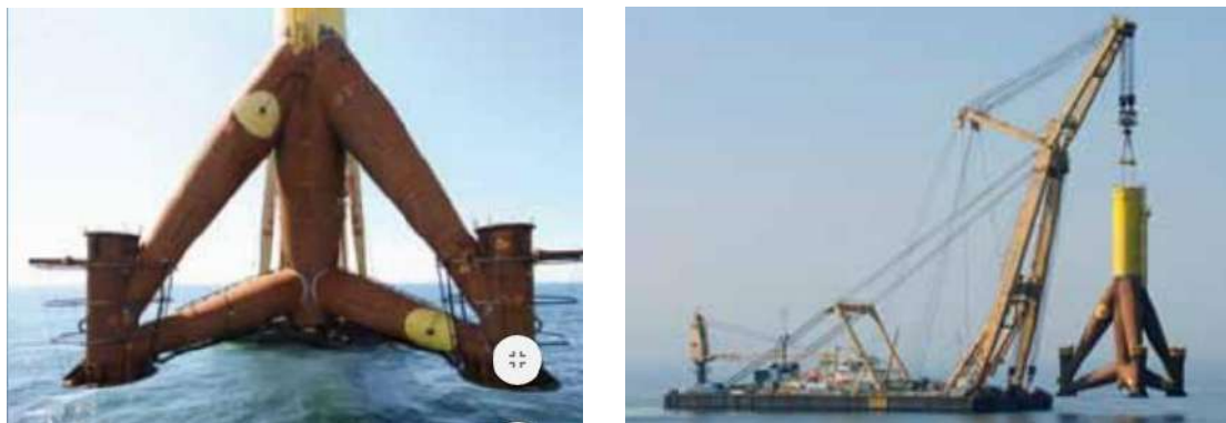
Figura 6. Colocación de estructuras de tipo trípode en el parque eólico de Alpha Ventus (fuente: www.aveva.com )
