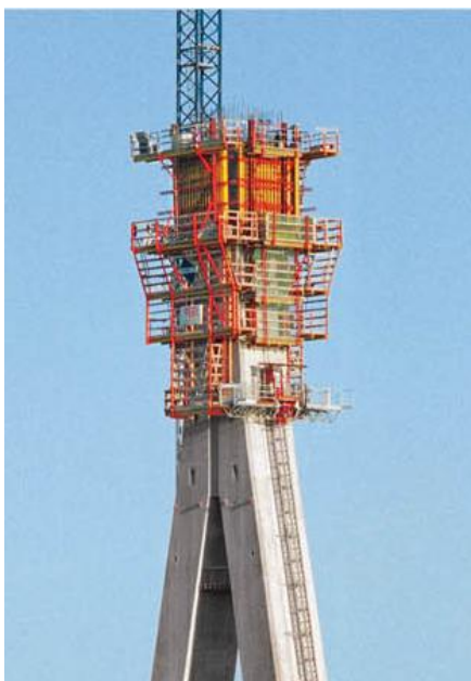
Figura 3 – Sistema de cofragem auto-trepante
