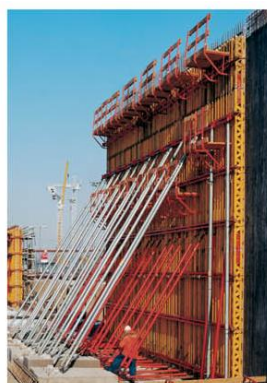
Figura 10 – Exemplo de prumos para cofragens verticais
