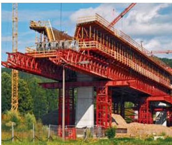
Figura 4 – Sistema de cofragem deslizante
