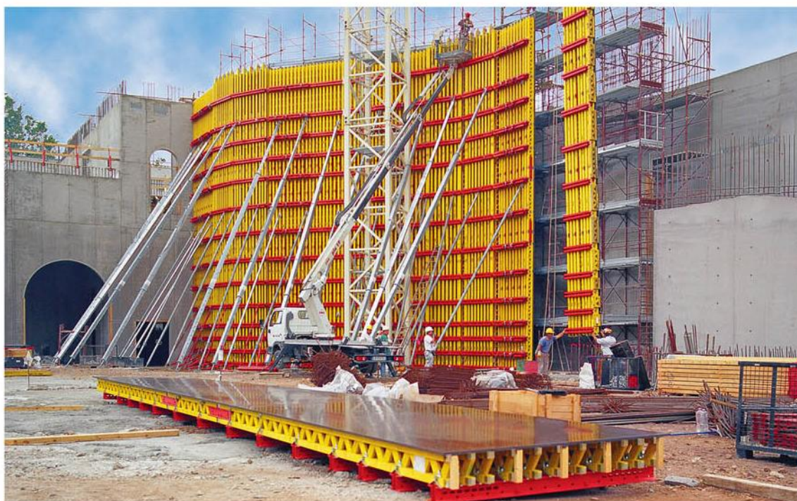
Figura 2 – Exemplo de uma cofragem vertical
