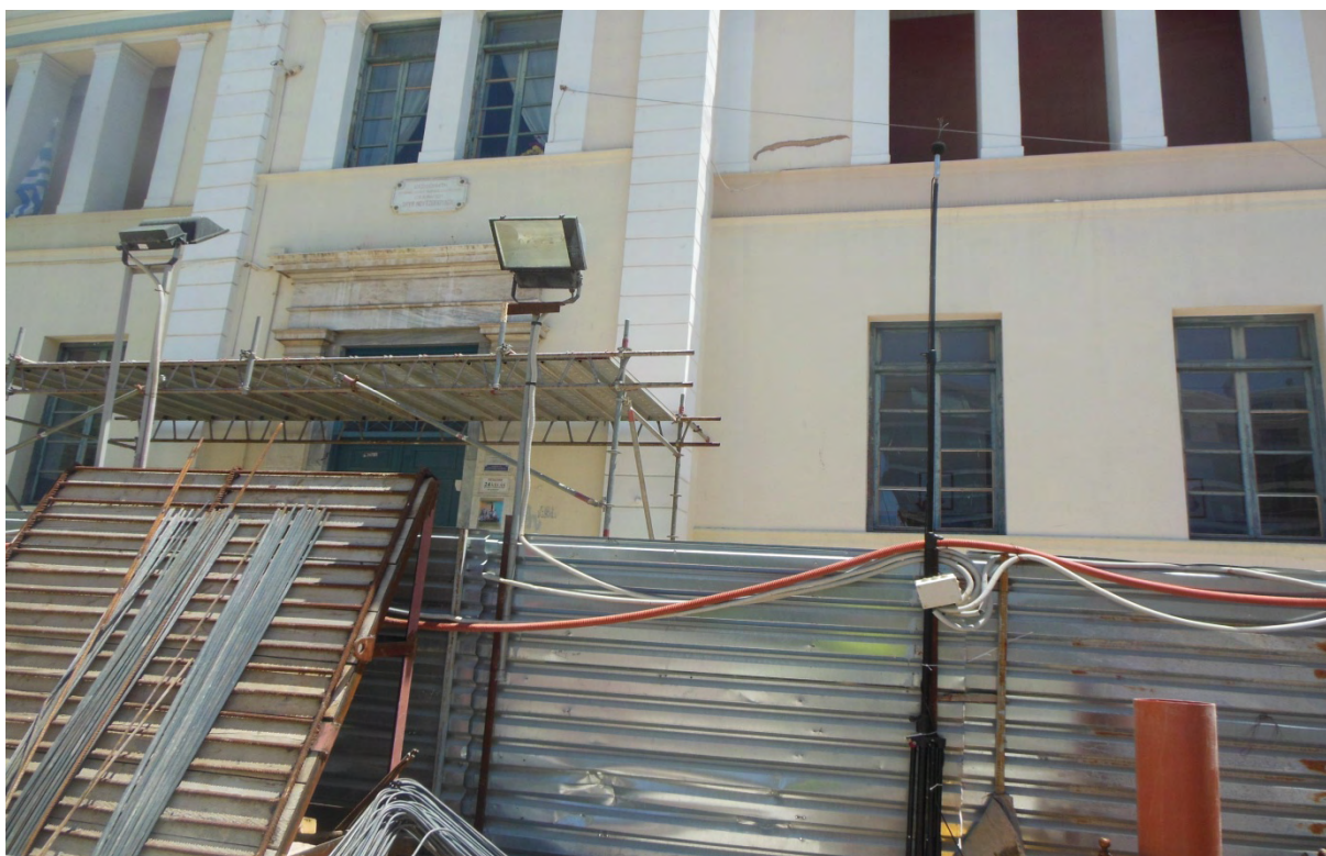
ΕΙΚΟΝΑ 7.8: ΕΡΓΟΤΑΞΙΟ «ΔΕΛΗΓΙΑΝΝΗ»- ΑΥΤΟΝΟΜΟΣ ΚΙΝΗΤΟΣ ΣΤΑΘΜΟΣ ΘΟΥΡΒΟΥ ΜΕ ΣΤΑΤΙΣΤΙΚΟ ΑΝΑΛΥΤΗ ΚΑΙ ΔΙΑΤΑΞΗ ΠΑΝΤΟΣ ΚΑΙΡΟΥ (ΣΕ ΕΙΔΙΚΟ ΙΣΤΟ) ΤΥΠΟΥ SOLO
