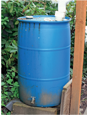
Figura 18: Ejemplo de sistema de captación y colección de agua de lluvia de los techos de casas.
