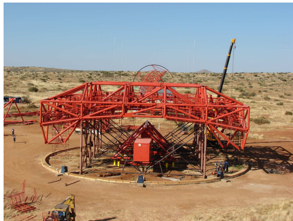
Fig. 2.16: Structure du support des miroirs pour H.E.S.S. II en cours de montage sur le site de H.E.S.S. . Crédits : Collaboration H.E.S.S.
