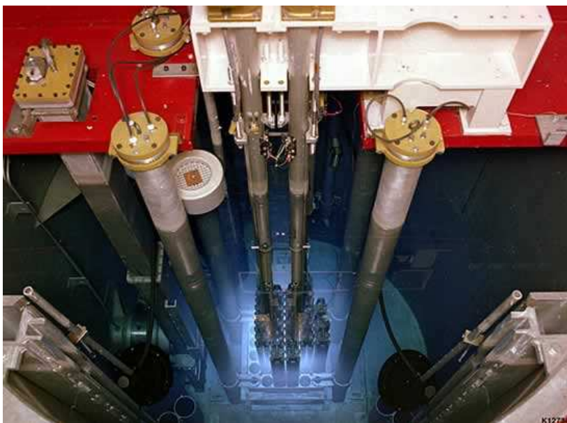
Fig. 1.10: Cœur d'un réacteur nucléaire. L'émission bleutée ČERENKOV y est clairement visible. L'épaisseur d'eau entre le cœur et le photographe est suffisante pour assurer la protection de celui-ci du rayonnement du cœur. Crédits : United States Department of Energy.
