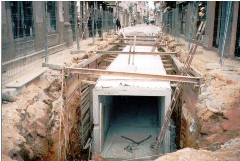
Figura 34- Galeria técnica visitável em construção no Centro Histórico de Barcelos
