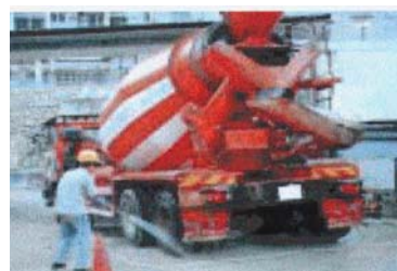
Figura 21- Lavagem do veículo antes de este abandonar o estaleiro
