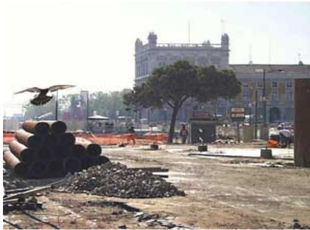
Figura 25- Exemplo de um estaleiro cuja vedação não contempla a minimização do impacto visual
