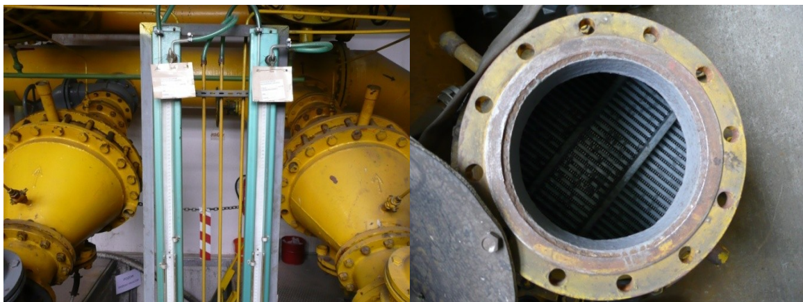
Obr. č. 6 - Kuličkové uzávěry s trubicovými U-manometry a pohled na štěrbínové síto
