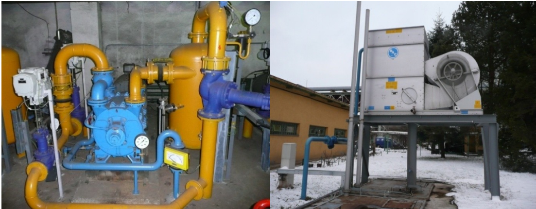
Obr. č. 3 – Vývěva 200-SZO-500-500 a chladič věž pro tzv. bezobslužný provoz
