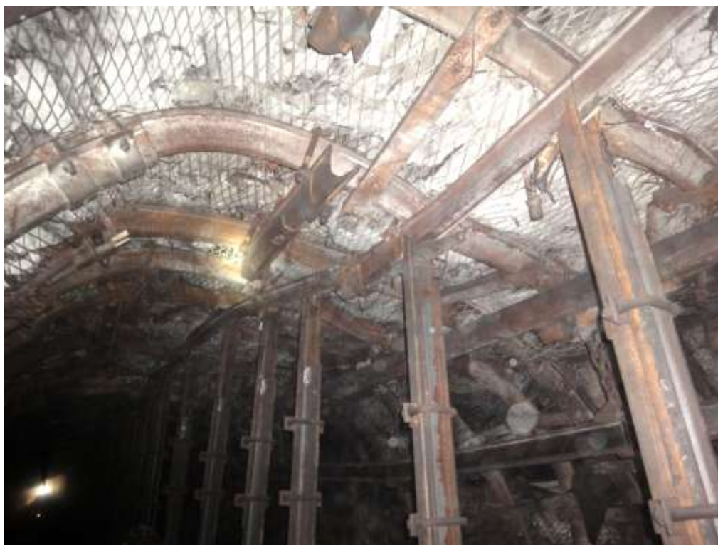
Obr. 19 Instalace stojin z tyčí profilu K 24 (P 28) na výdušné třídě porubu 063 606. Foto: D. Sulava
