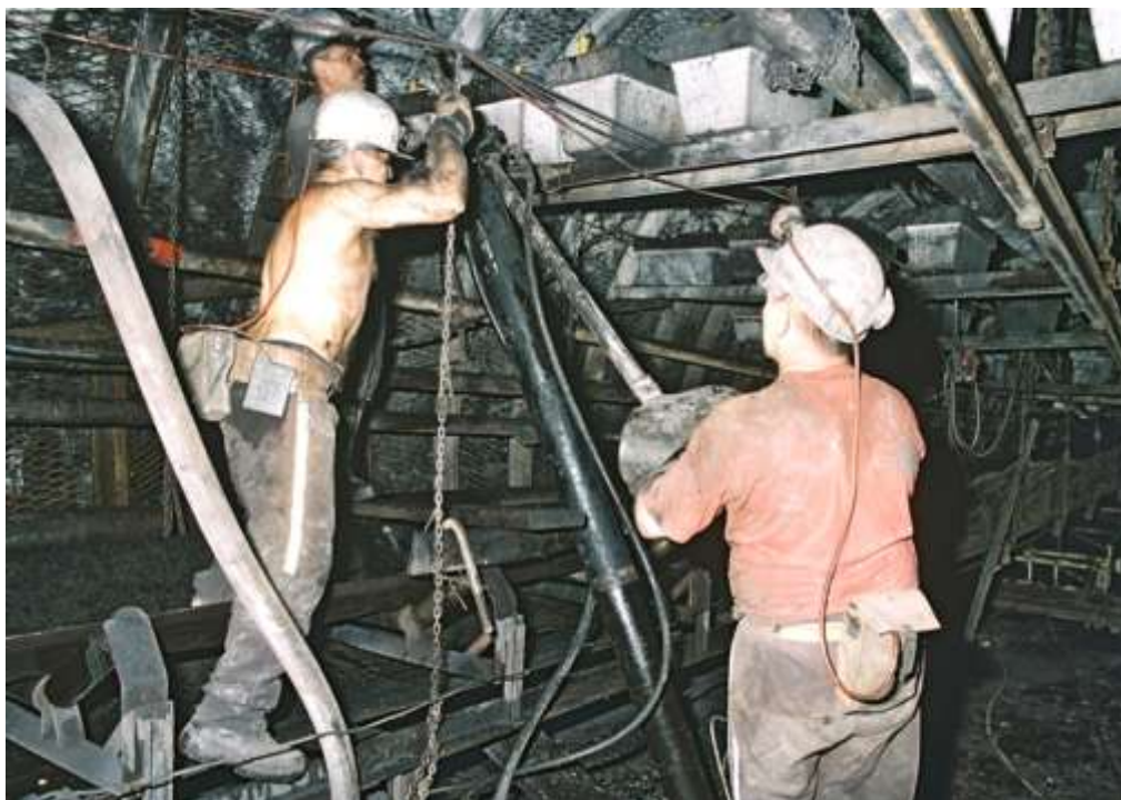
Obr. 16 Instalace pramencové kotvy pomocí vrtací a svorníkovací soupravy Super Turbo Bolter firmy Minova. Foto: L. Mazal
