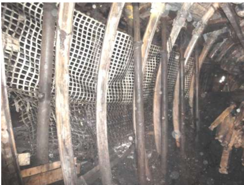
Obr. 2 Budování SH stojek v prostoru stavby žebra. Foto: D. Sulava
