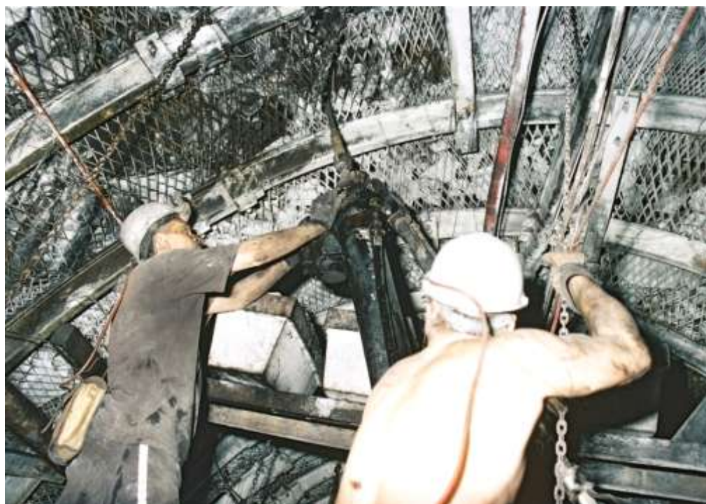
Obr. 17 Instalace pramencové kotvy pomocí vrtací a svorníkovací soupravy Super Turbo Bolter firmy Minova. Foto: L. Mazal
