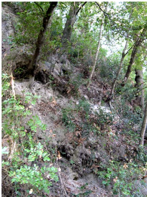
Figura 15 – Condizioni di erosione del substrato e precaria stabilità degli alberi in corrispondenza di pendice a inclinazione superiore ai 50°
