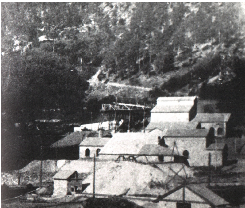
Figura 13 - Lo stabilimento della Torretta per il trattamento del minerale, fotografato nel primo decennio del secolo scorso (foto Herbet)
