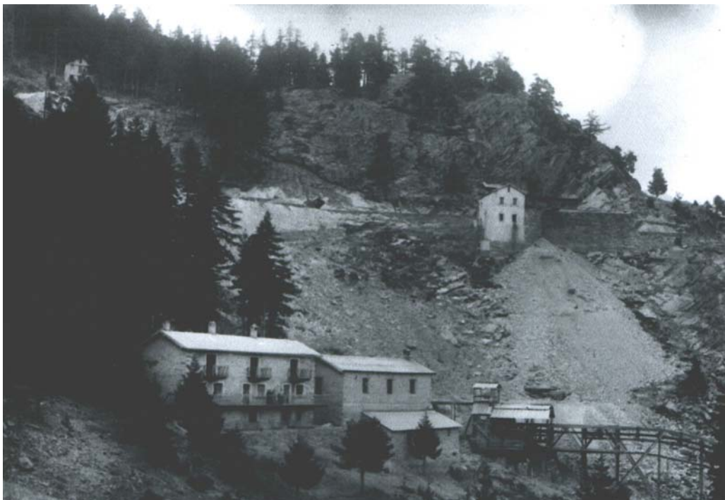
Figura 12 - Fabbricati e stazione di partenza della teleferica alle miniere di Bechaz, nel primo decennio del secolo scorso (foto Herbet)
