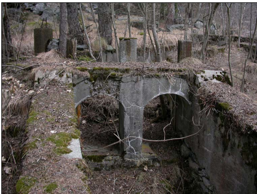
Figura 17 - Strutture in cemento della presa d'acqua delle strutture idroelettriche lungo il torrente Evançon (foto Cesti)
