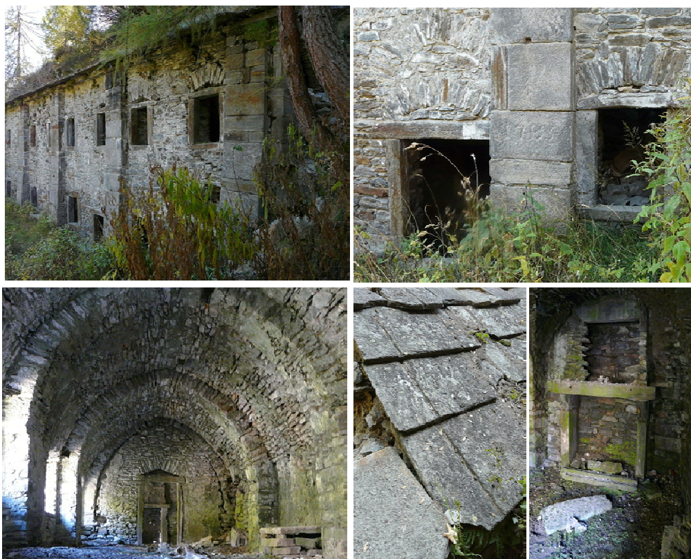
Figura 5 - Alagna, il 'baracone' di Santa Maria per il ricovero dei minatori: particolari architettonici esterni ed interni dello splendido manufatto, crollato quattro anni or sono (immagini da www.in-montagna.it )
