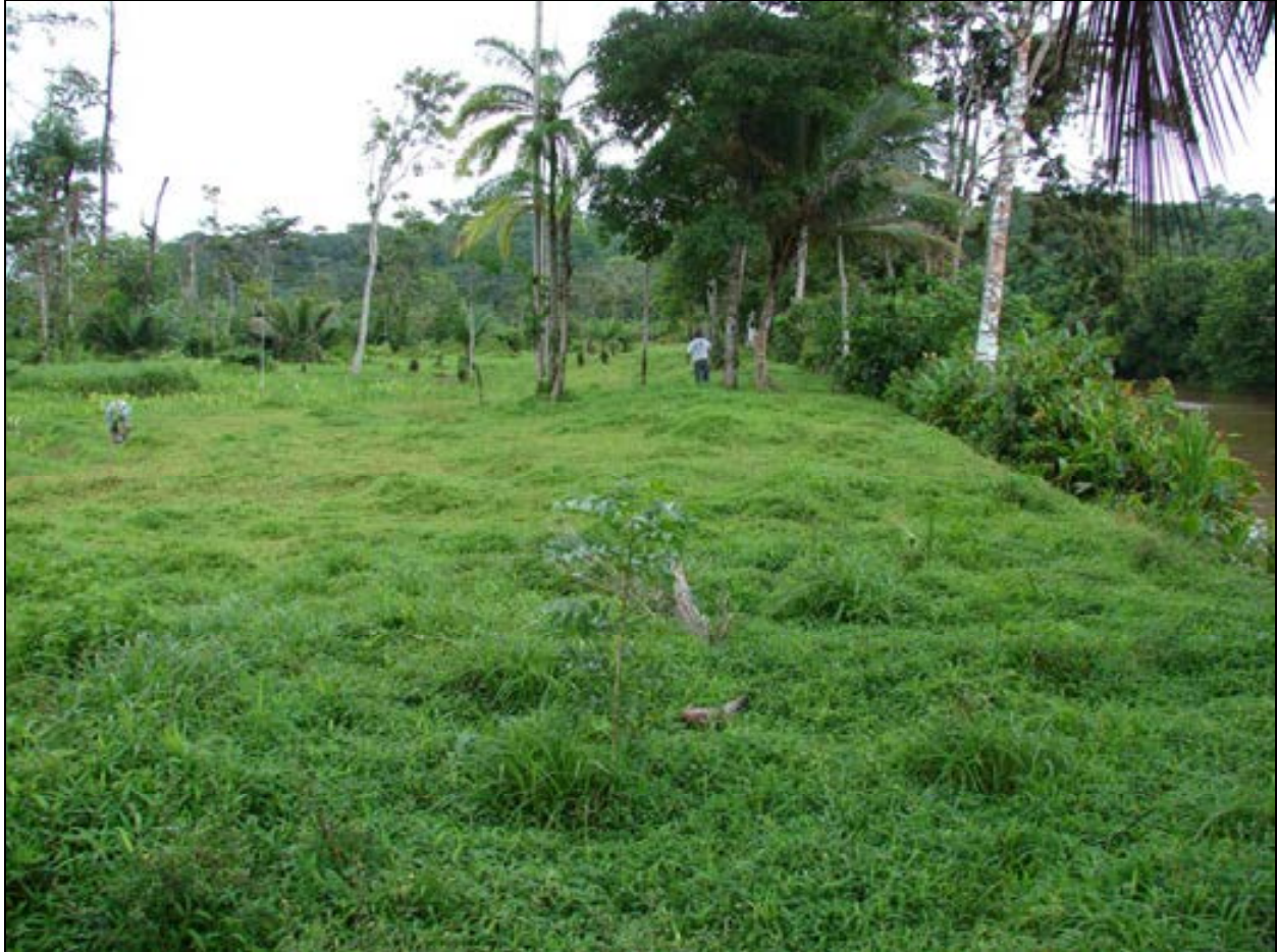
Figura 77. Dique o levée y terraza baja en la margen derecha del río Indio a su paso por la comunidad de Chilar (Fecha: 08/08/06)
