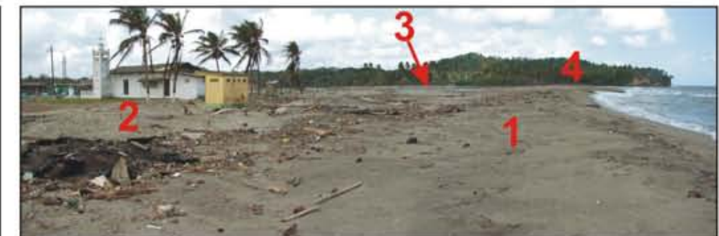
Playa (1) con berma de tormenta (2) en la desembocadura del río Miguel de la Borda (3). Al fondo vertientes y acantilados (4) en areniscas (Oligo-Mioceno) de la formación Caimito (Fecha: 18/III/07)
