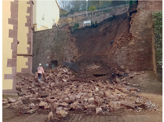
Wertheim, Stützmauer am ehemaligen Dekanat.
