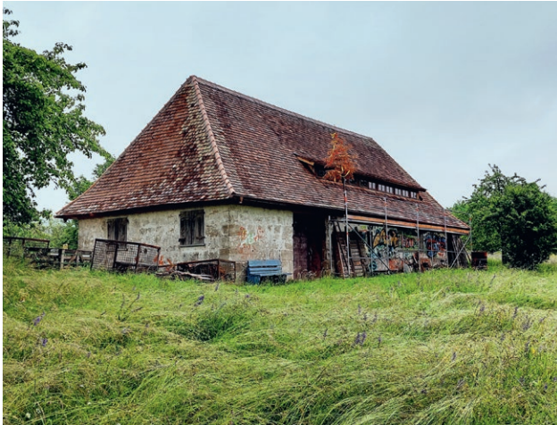
Weissach im Tal-Bruch, Alte Kelter.
