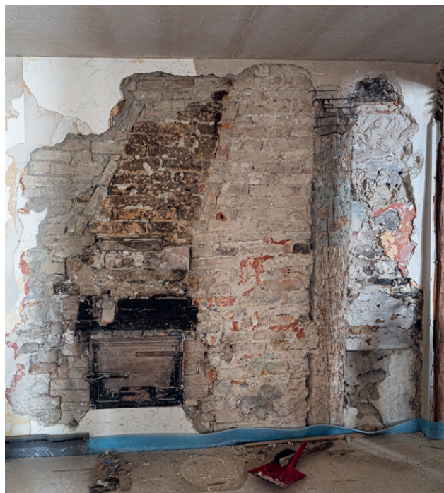
Hinter Verblendungen der 1960er Jahre kamen Feuerstellen und Kaminmauerwerk zutage.
