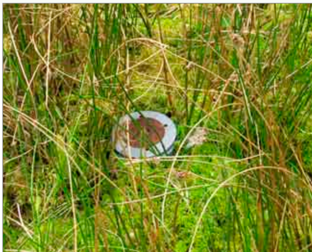
Piezometr, w którym znajduje się miernik poziomu wody. Pokrywa jest normalnie zakryta torfem.
