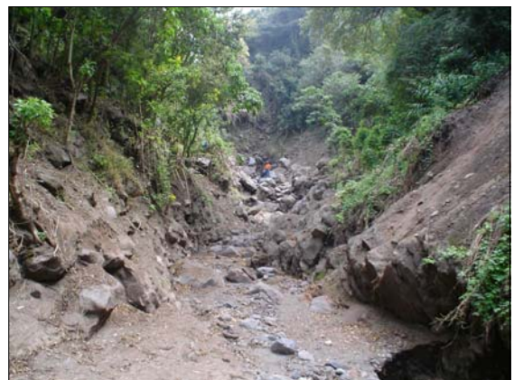
Figura 9. Vista de canal de flujo de Pachichaj, donde se observan las marcas del área por donde escurrió el material. Al fondo se observa una acumulación de bloques de roca que podrían ser removidos en el futuro.
