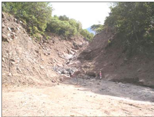
Figura 5. Desembocadura del canal por donde escurrió el material del Flujo Norte ( F_n ). Se observan el incremento de dimensiones del canal debido a la abrasión del material arrastrado. Vista al este.
