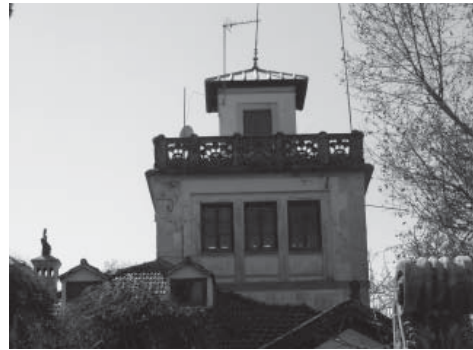
11. Rejería de Avenida de Andalucía s/n.
