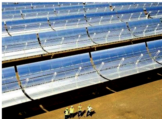
Figura 7. Colectores de tipo canal parabólico (Fuente: Wikipedia).
