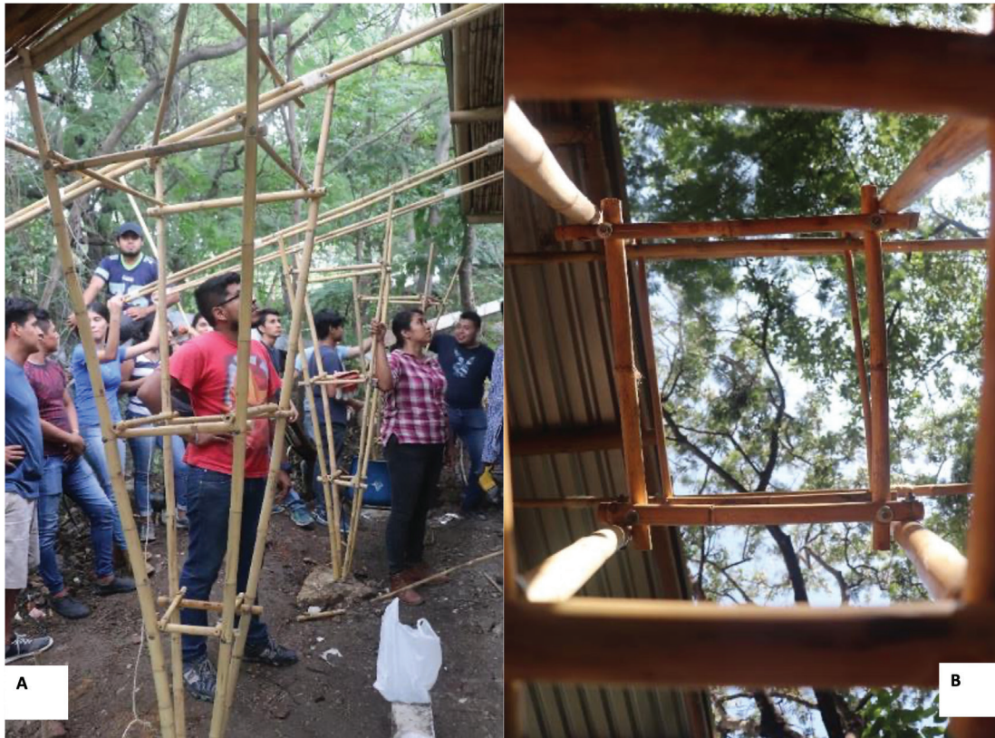
Figura 3. Estructuras ligeras desarrolladas en el taller en las instalaciones de la Facultad de Arquitectura de la Universidad Autónoma de Chiapas, México. A) Elementos estructurales a base de Otatea fimbriata (Guich). B) Interior de estructura ligera.
