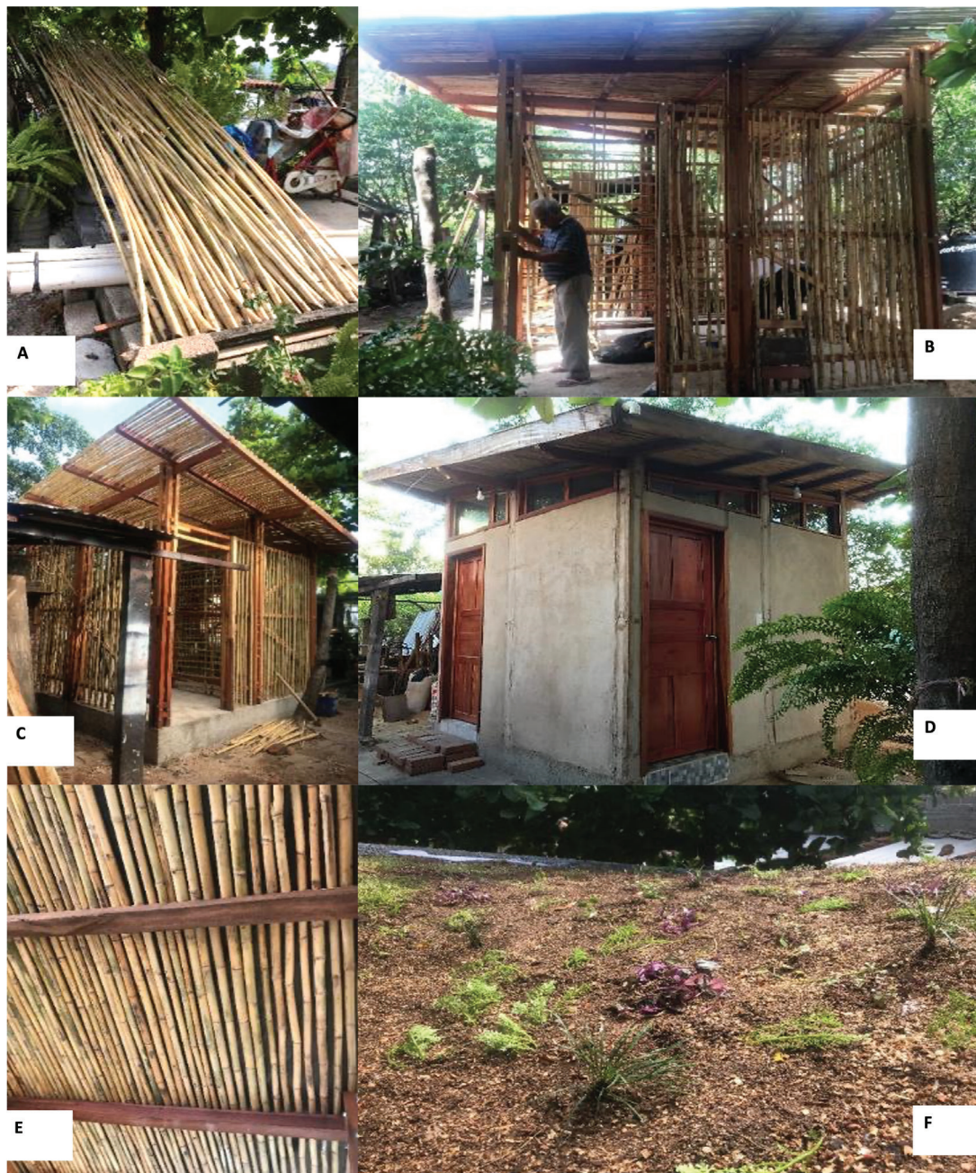
Figura 4. Módulo Sanitario con cubierta verde hiperbólica en el que se emplean materiales regionales para erigir los componentes estructurales de muros y cubierta. A) Culmos de Otatea fimbriata Soderstr. (Guich). B) y C) Estructura de muros y cubierta a base de madera y Otatea fimbriata . D) Módulo sanitario donde se identifica la composición de los muros a base de tierra. E) Elementos horizontales de Guich en la composición estructural de la cubierta. F) Cubierta verde sobre la estructura del baño.
