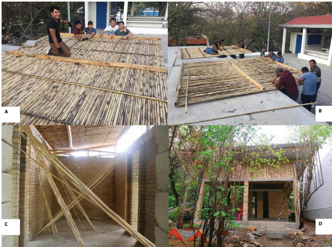
Figura 2. Vivienda Climáticamente Inteligente desarrollada por Alumnos de la Facultad de Arquitectura de la Universidad Autónoma de Chiapas, México. A) Elaboración de panel en el piso a base de varas de Otatea fimbriata (Guich). B) Paneles para cubierta a base de Otatea fimbriata . C) Interior de la vivienda Climáticamente Inteligente. D) Perspectiva exterior de la vivienda donde se aprecian los materiales empleados para su concepción (tierra y bambú) Fuente: [17].
