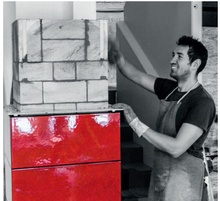
Ausmauerung eines WALAN
