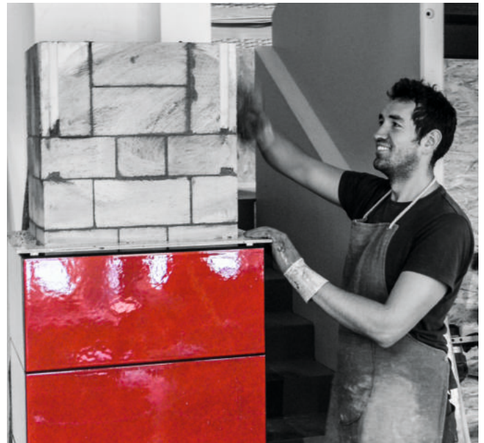
Ausmauerung eines WALAN
