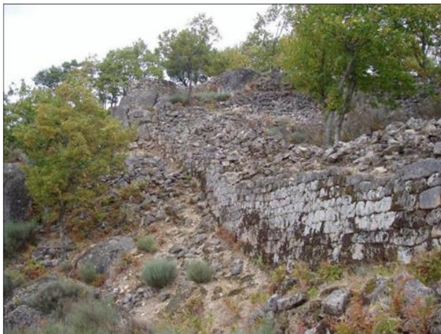
Fig. 11. Pormenor do aparelho poligonal da muralha da Cerca de Ribas, notando-se em cima o torreão. Fig. 11. Detail of the polygonal bond at Cerca de Ribas, with the turret above.
