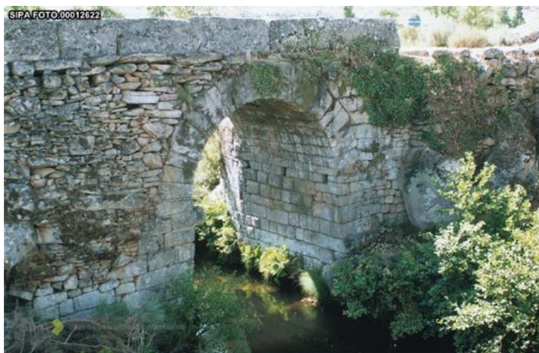
Fig. 21. Ponte do Arco ou de Barrela (© Sistema de Informação para o Património Arquitectónico - SIPA, Instituto da Habitação e da Reabilitação Urbana, I.P. – IHRU).
