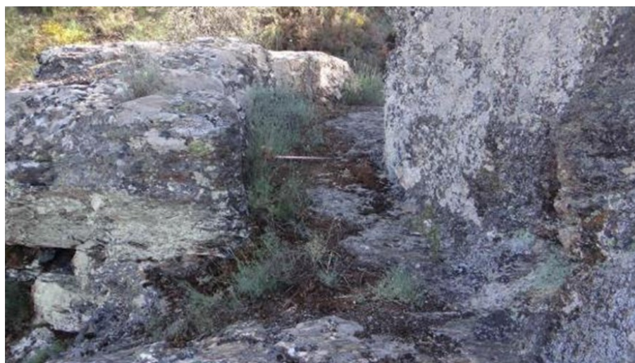
Fig. 15. Troço de canal escavado na rocha na zona das “Fragas Cortadas”. Fig. 15. Section of the channel carved into the rock in the area of “Fragas Cortadas”.
