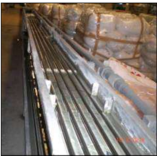
Φωτογραφία 4.2.2.9-3: Σύστημα ψύξης
