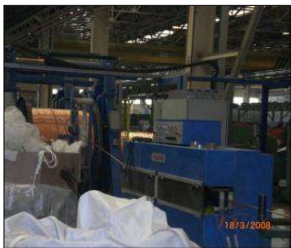
Φωτογραφία 4.2.2.4-1: Μηχανή μόνωσης- εκτύλιξη αγωγού για μόνωση
