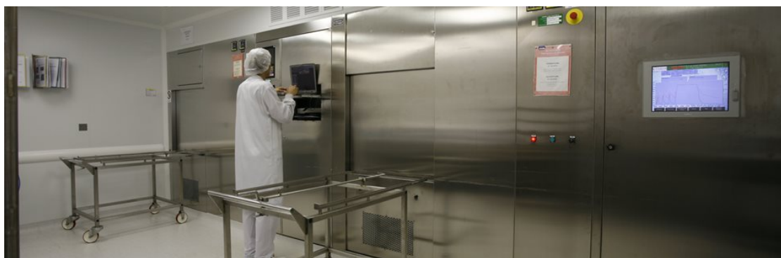
Εικόνα 23 Φωτογραφία από το εσωτερικό των εγκαταστάσεων ψύξης φαρμάκων
