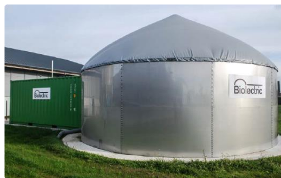
Figure 3.12: Αναπαράσταση της ήδη υπάρχουσας εγκατάστασης αναερόβιας χώνευσης “Bioelectric”
