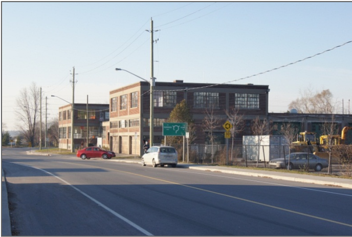
Figure 36 : Ancien bâtiment des Travaux publics au 7 chemin Bayview
