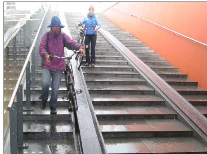
Figure 56 : Rampes pour vélos dans un escalier
