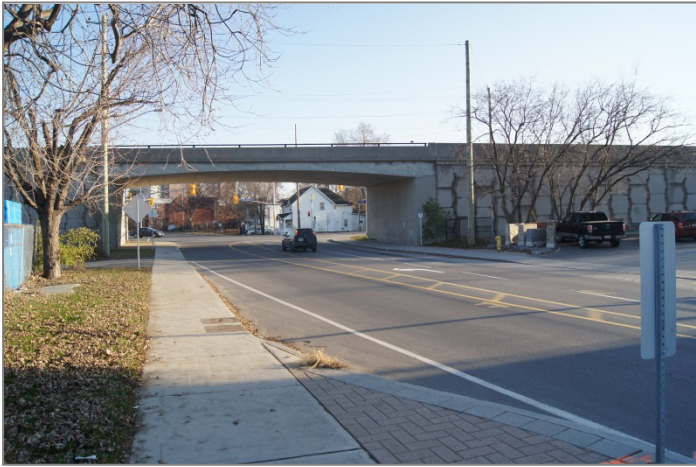
Figure 23 : Le pont du Transitway sert de barrière entre la gare de triage Bayview et la rue Scott
