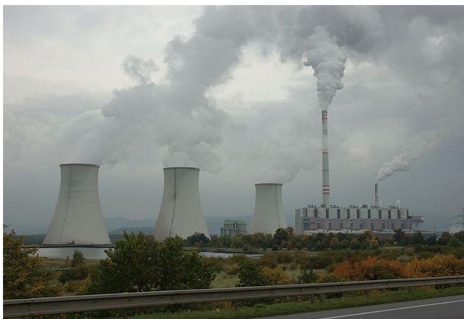
Obr. 5. Uhelná elektrárna Pruněřov II o výkonu 1,5 GW. Obrázek převzat z [22].
