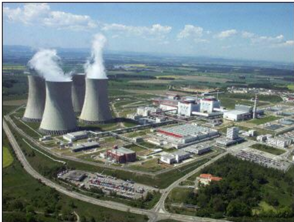
Obr. 9. Jaderná elektrárna Temelín. Z chladicích věží unikají oblaka zkondenzovaných vodních par. Převzato z [26].
