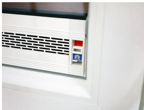
Obrázek 2b - větrací systém Renson – ventilační klapka do skla [3]
