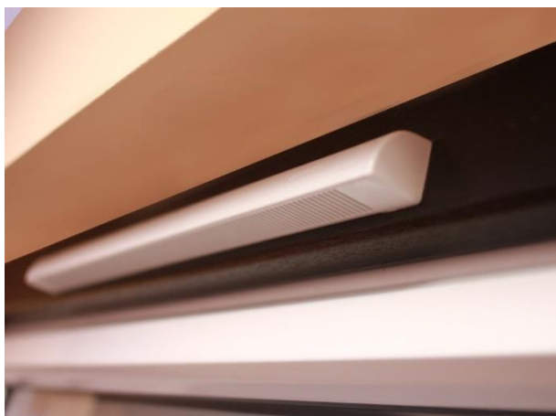
Obrázek 2a - větrací systém Aireco - větrací štěrba na okno [2]
