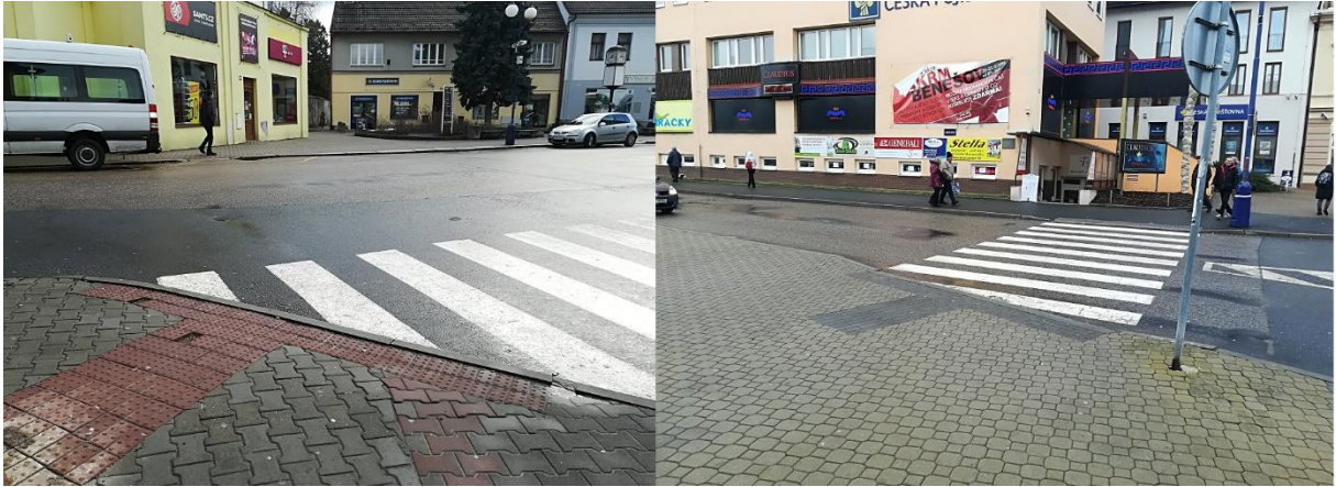
Obrázek 12 Chybně provedené přechody pro chodce, Vnoučkova ulice, Benešov, autor: Hlubučková, 2019
