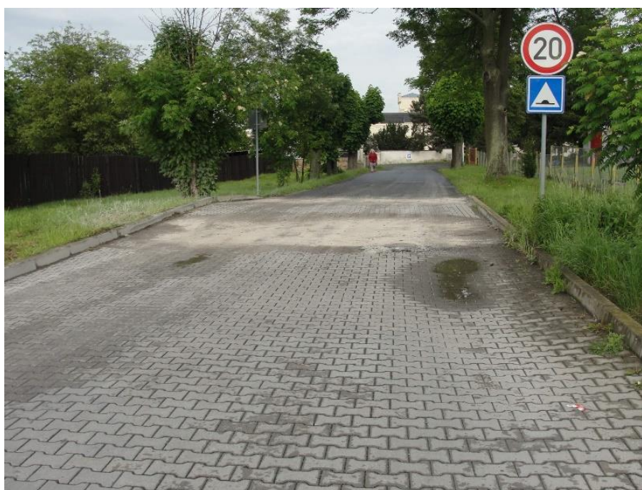
Obrázek 14: Místní komunikace z betonové dlažby [50]
