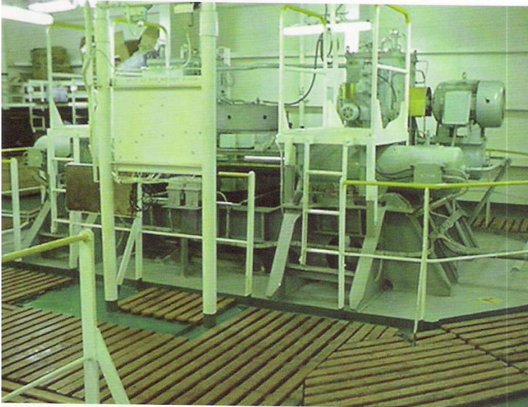
Εικόνα γ47 : Steering gear room in good condition
