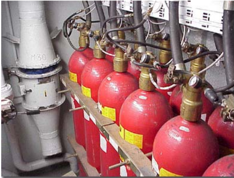
Εικόνα γ27: Fixed fire extinguishing system gas bottles
