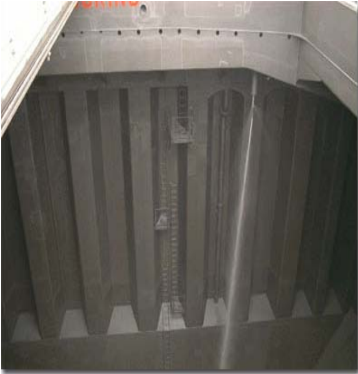
Εικόνα γ49 : Bulkhead good condition
