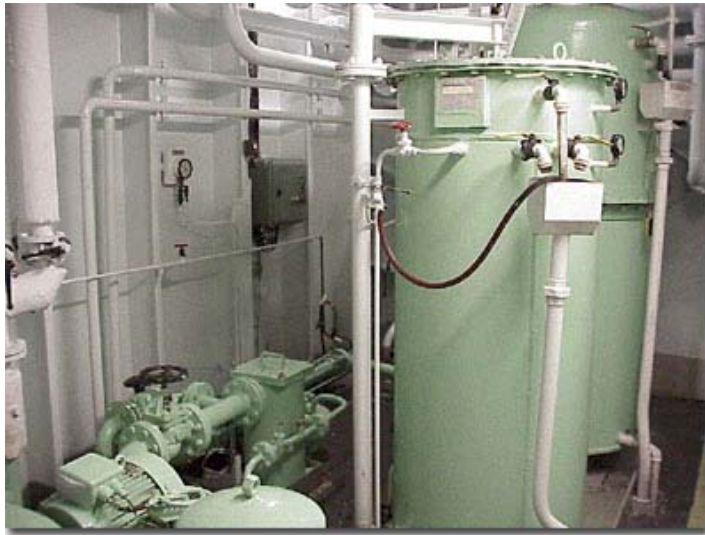
Εικόνα 16 : Oil water separator
