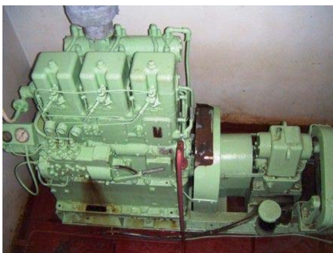
Εικόνα 13: Emergency fire pump
