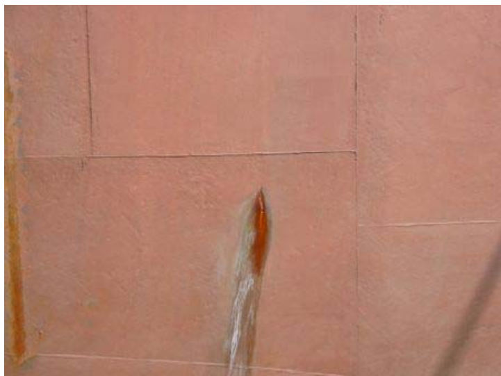
Εικόνα γ51: Hull crack
