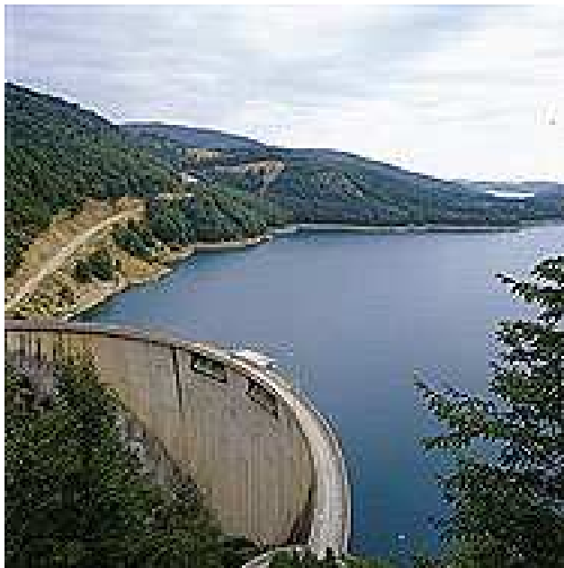
Εικόνα 3.3: Η περιοχή του φράγματος στη λίμνη Πλαστήρα
