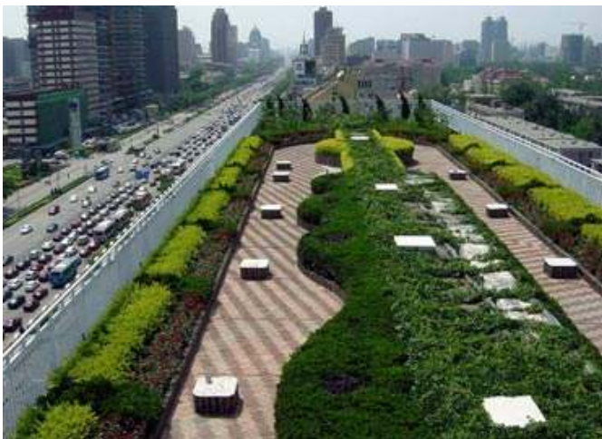
Εικόνα 3.5 Πράσινη στέγη κτιρίου Πεκίνο 17
