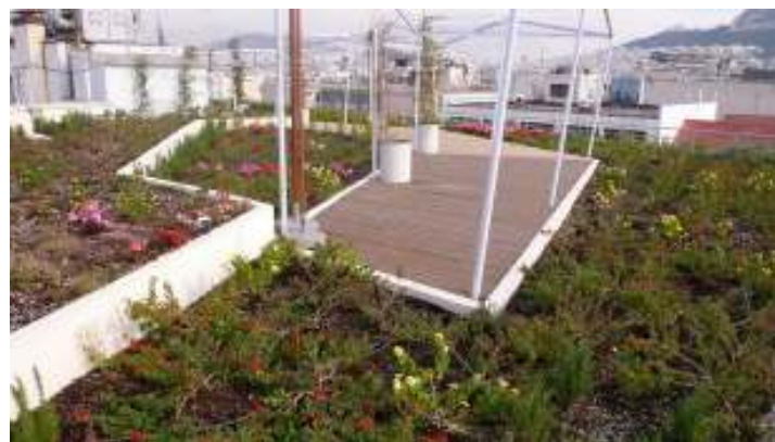
Εικόνα 2.2 Η πράσινη στέγη του κτιρίου Διοίκησης ΗΣΑΠ στο κέντρο της Αθήνας 15
