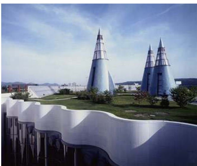
Εικόνα 3.6 Πράσινη οροφή κτιρίου Art and Exhibition Hall στη Βόννη της Γερμανίας 17
