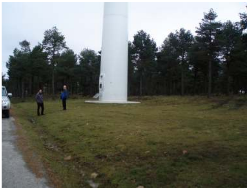
Φωτογραφία 6.5.1. Φυσική αποκατάσταση πλατώματος ανεμογεννήτριας
