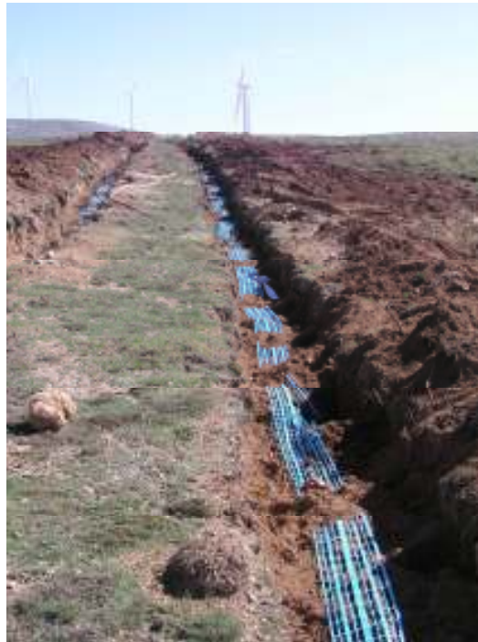
Φωτογραφία 4.2.2. Κανάλια υπόγειων καλωδιώσεων αιολικών πάρκων
