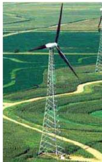
Φωτογραφία 2.4.1 Α/Γες με σωληνωτό και δικτυωτό πύργο αντίστοιχα
