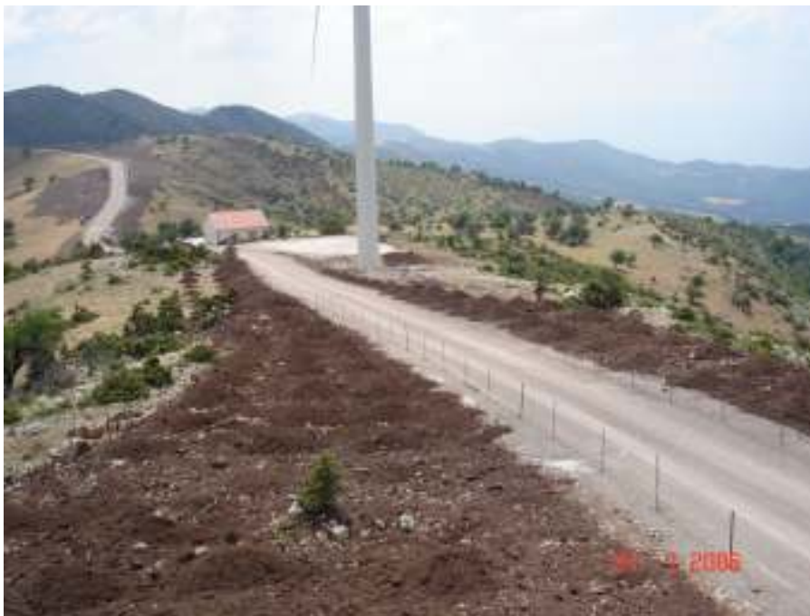
Φωτογραφία 6.5.2. Εργασίες αποκατάστασης διαταραχθέντων χώρων από την κατασκευή οδοποιίας αιολικού πάρκου
