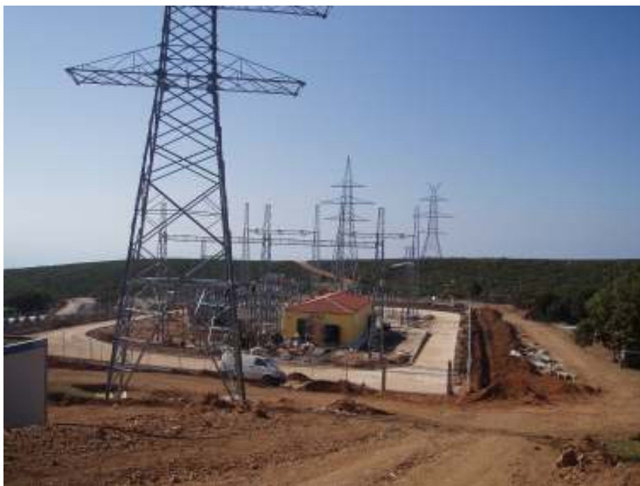
Φωτογραφία 4.3.1. Κατασκευή Υποσταθμού Ανύψωσης 20/150kV αιολικού πάρκου Παναχαϊκού όρους
