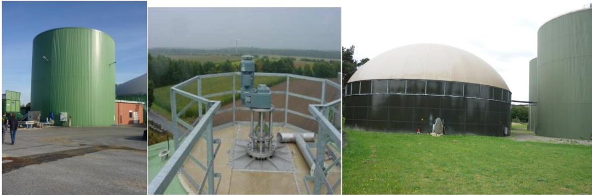
Εικόνα 11.8: Πρωτεύων κατακόρυφος χωνευτήρας (αριστερά), αναδευτήρας στη κορυφή του πρωτεύοντα χωνευτήρα, (μέση) δευτερεύων χωνευτήρας καλυμμένος από αεροστεγή μεμβράνη. Η μεμβράνη διογκώνεται από το παραγόμενο βιοαέριο (δεξιά) [84]
