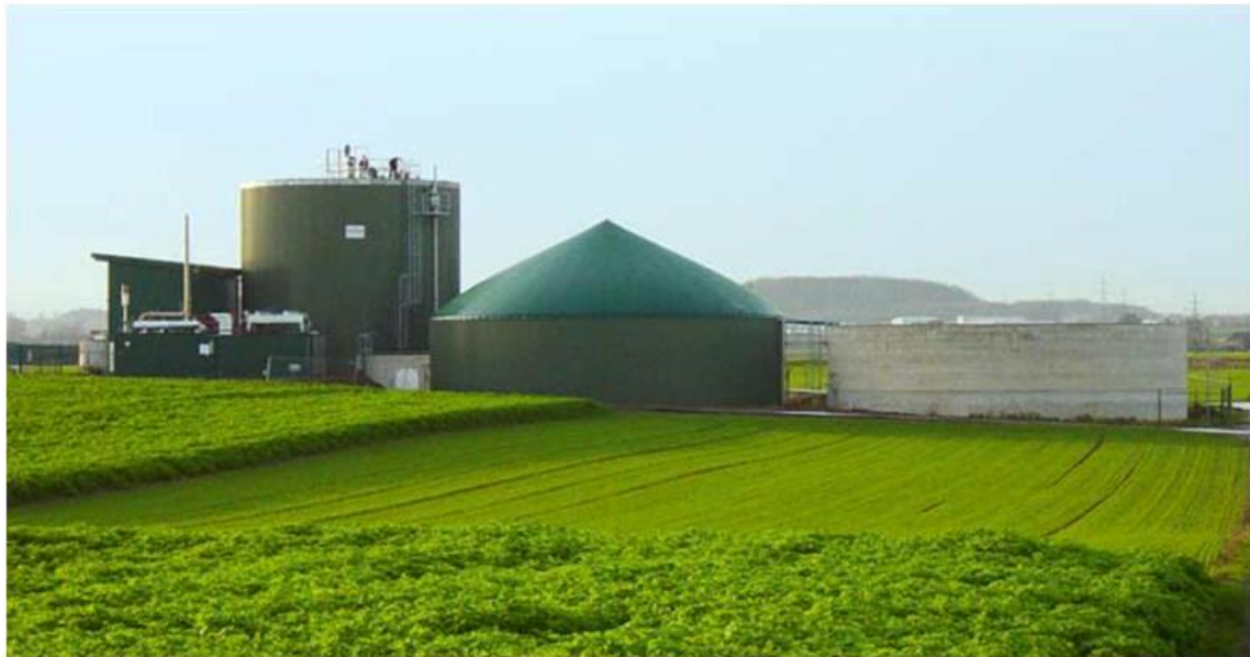
Εικόνα 5.4 : Εγκατάσταση βιοαερίου στη Γερμανία που κατασκευάστηκε το 2005 από 99 αγρότες για την χώνευση των ενεργειακών καλλιεργειών, ενσίρωμα καλαμποκιού και σιταριού. [84]
