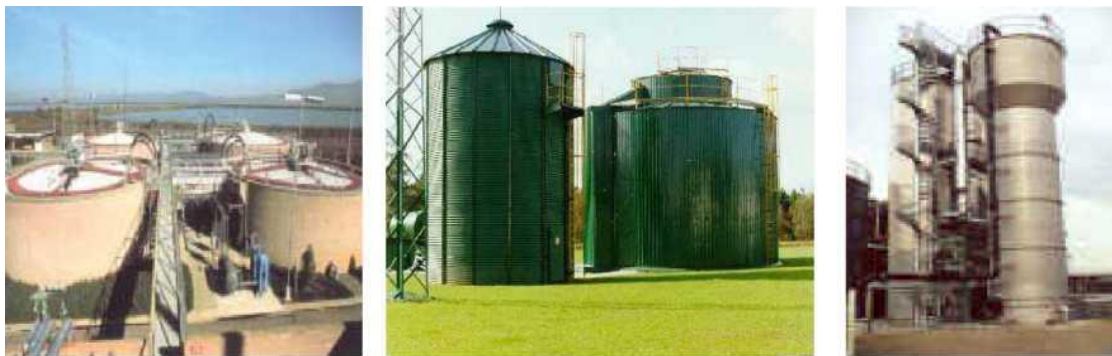
Εικόνα 4.1 Διακρίνονται α) αριστερά, αναερόβιοι χωνευτήρες για την επεξεργασία ενεργού λύσος στον Σαν Φρανσίσκο της Αμερικής, β) στη μέση, αναερόβιοι χωνευτήρες και γ) δεξιά, διάταξη ταυτόχρονης αναερόβιας και αερόβιας επεξεργασίας αστικών λυμάτων και βιομηχανικών αποβλήτων στην Αμερική [84]
