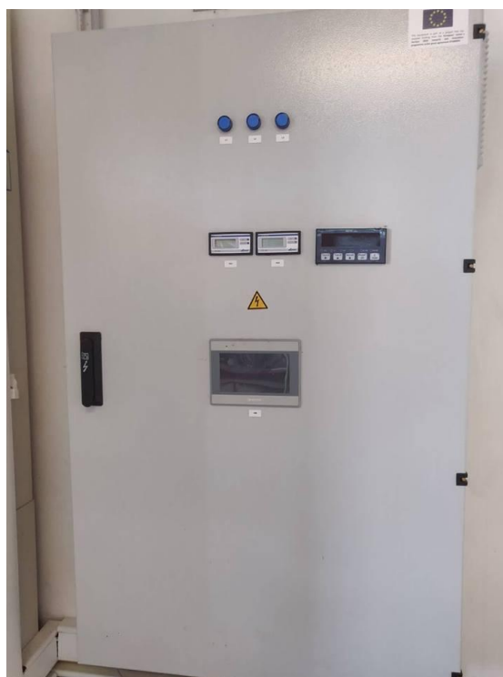
Σχήμα 10: Πίνακας Ελέγχου PLC
