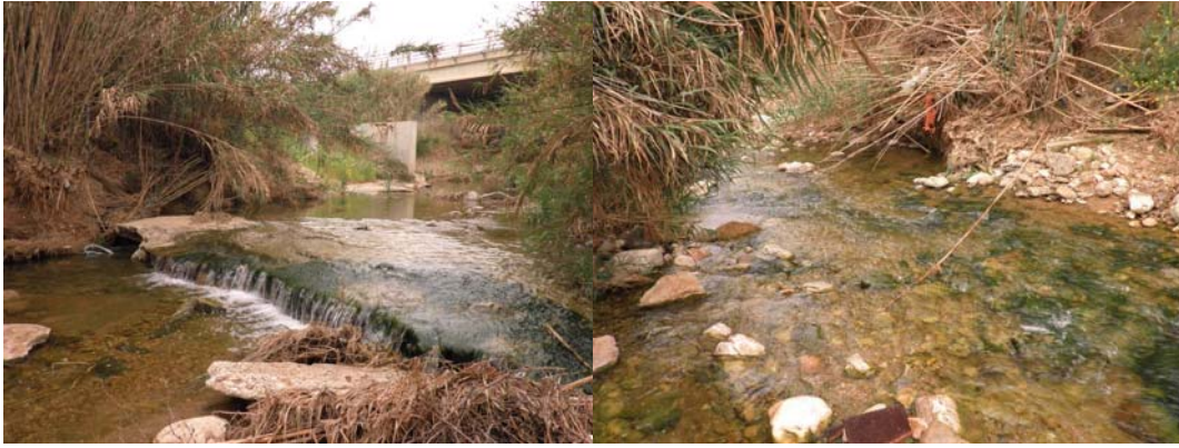
Σχήμα Π7.7: Φωτογραφική τεκμηρίωση της θέσης S7.
