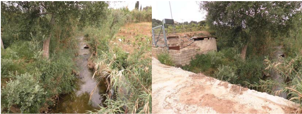
Σχήμα Π7.8: Φωτογραφική τεκμηρίωση της θέσης S8.
