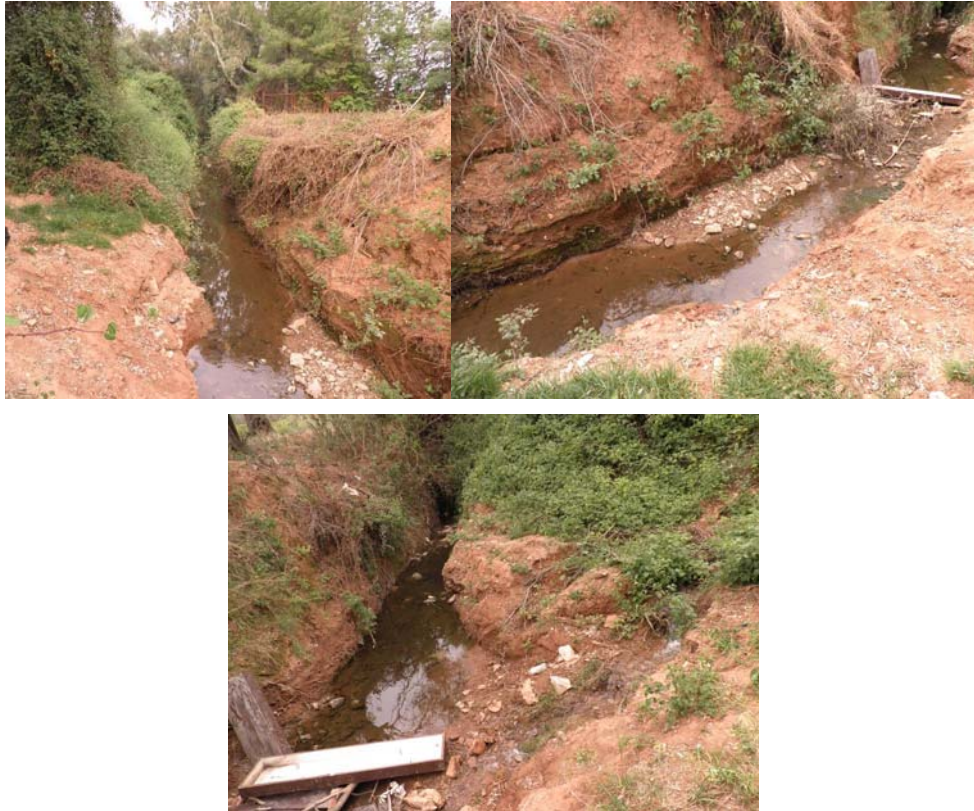
Σχήμα Π7.3: Φωτογραφική τεκμηρίωση της θέσης S3.
