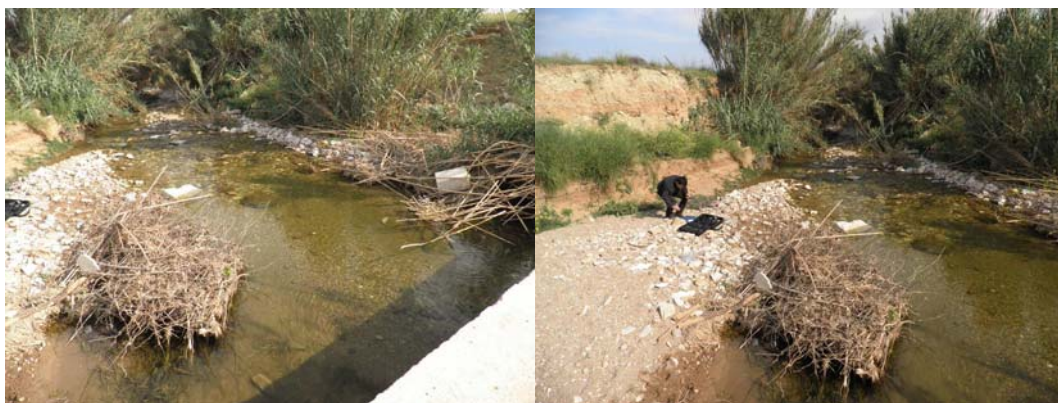
Σχήμα Π7.11: Φωτογραφική τεκμηρίωση της θέσης S10.
