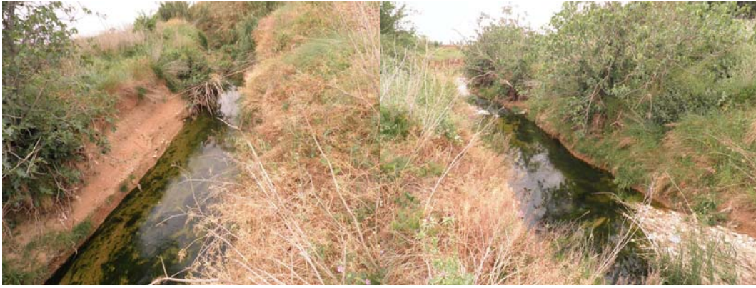
Σχήμα Π7.5: Φωτογραφική τεκμηρίωση της θέσης S5.
