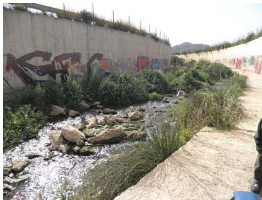
Σχήμα Π7.2: Φωτογραφική τεκμηρίωση της θέσης S2.
