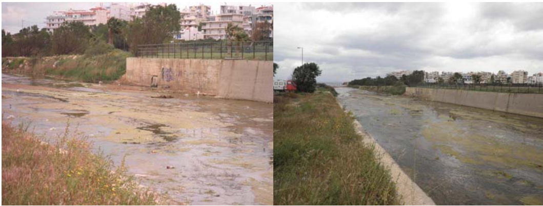
Σχήμα Π7.20: Φωτογραφική τεκμηρίωση της θέσης S20.
