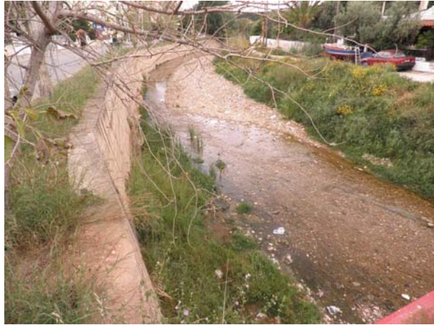
Σχήμα Π7.19: Φωτογραφική τεκμηρίωση της θέσης S19.
