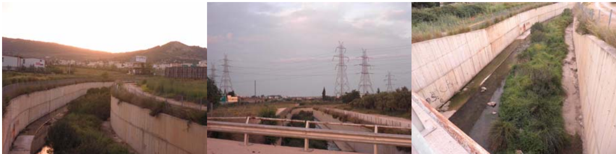
Σχήμα Π7.1: Φωτογραφική τεκμηρίωση της θέσης S1.
