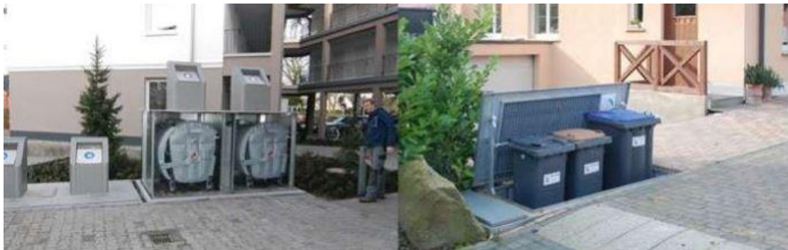
Εικόνα 10. Τοποθέτηση κάδων σε υπόγεια εγκατάσταση. Πηγή: Google
