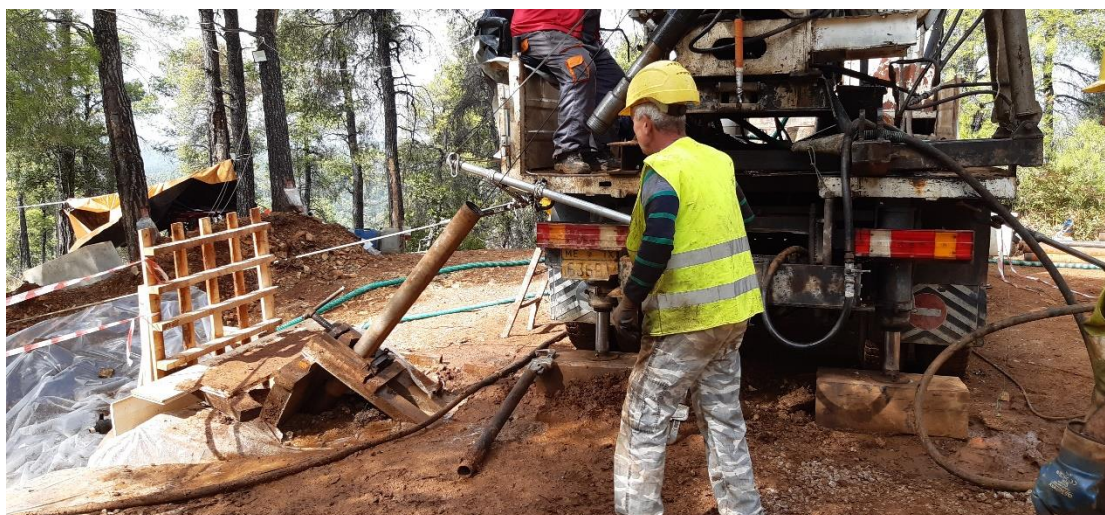
Εικόνα 5.11: Κεκλιμένη ερευνητική γεώτρηση στην περιοχή
