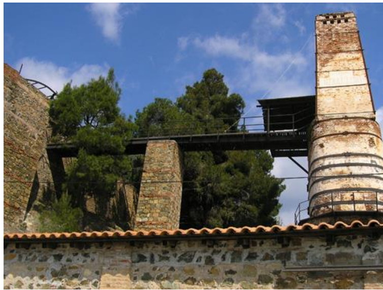
Εικόνα 5.16: Κάθετος φούρνος και γέφυρα μεταφορών ( www.monumenta.org )
