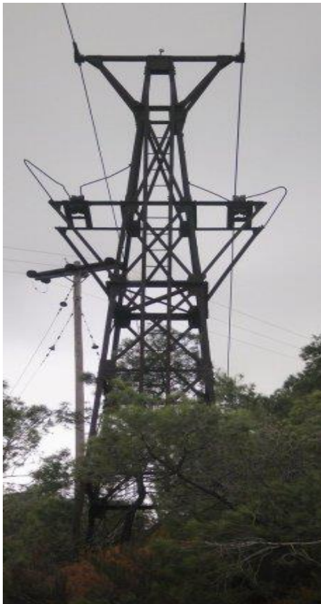
Εικόνα 5.14: Πυλώνας εναέριας μεταφοράς (www.monumenta.org)
