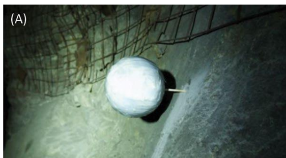
Εικόνα 3.8: Μία σφαίρα-στόχος τοποθετημένη στο τοίχωμα σήραγγας
