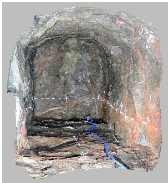
Εικόνα 2.5: Τρισδιάστατο μοντέλο υπόγειας εκσκαφής με πραγματικά χρώματα (Feng, 2012)
