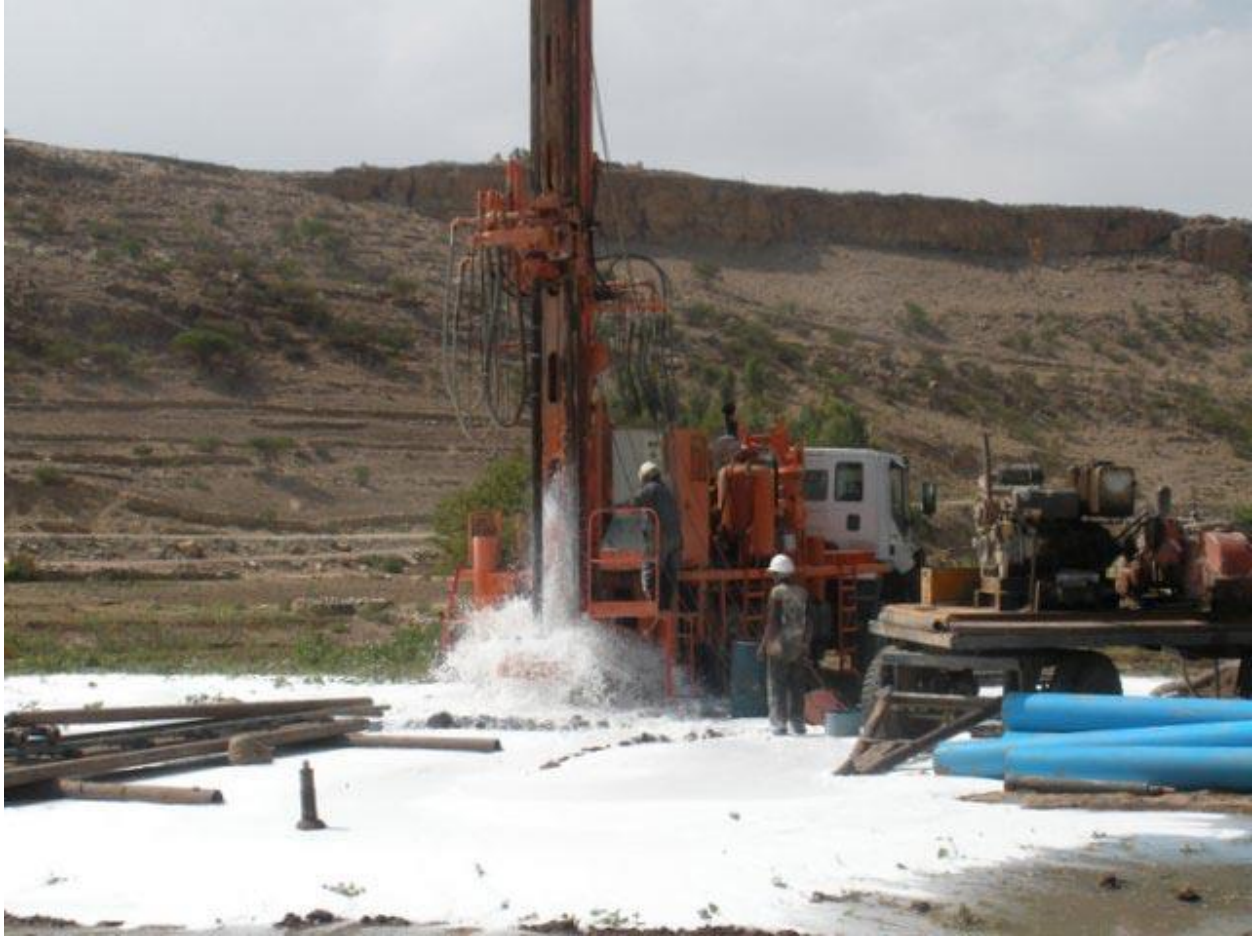
Εικόνα 6-10. Χρήση αφρού ως ρευστού διάτρησης (Πηγή: https://www.asecexport.org/drilling-chemicals/ )
