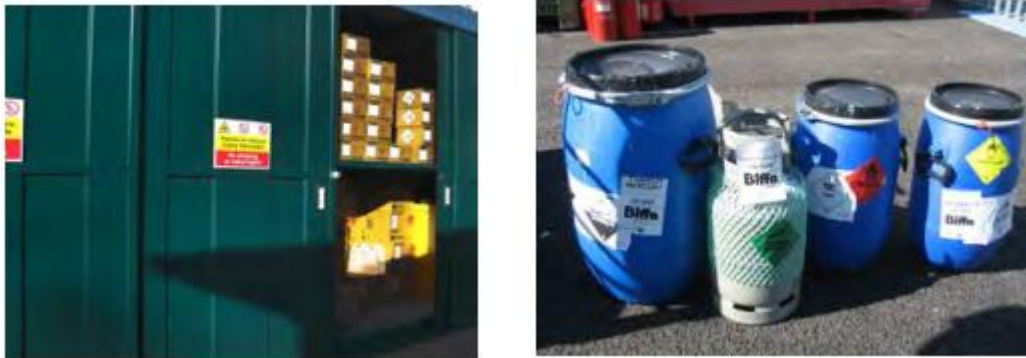
Σχήμα 13. Αριστερά: Προηγμένη αποθήκευση χημικών σε διαφορετικές θέσεις, Δεξιά: Αποθήκευση υγρών χημικών αποβλήτων σε ανθεκτικούς πλαστικούς περιέκτες (WHO, 2014).
