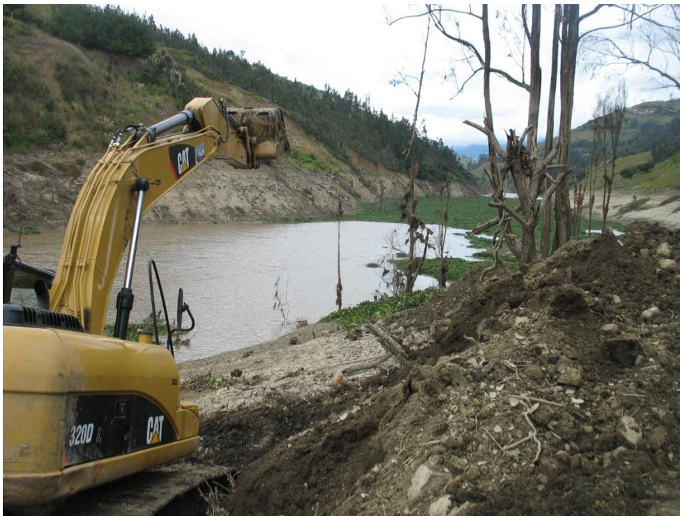
Foto 9.- Extracción Mecánica de lechuguin.
